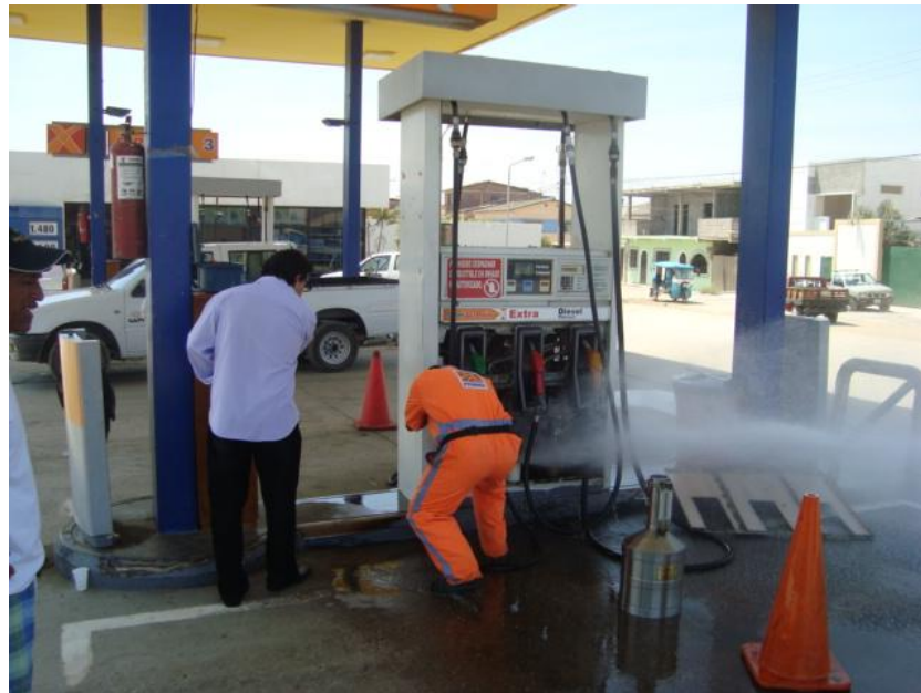
FIGURA 2 FUGA DE COMBUSTIBLE
