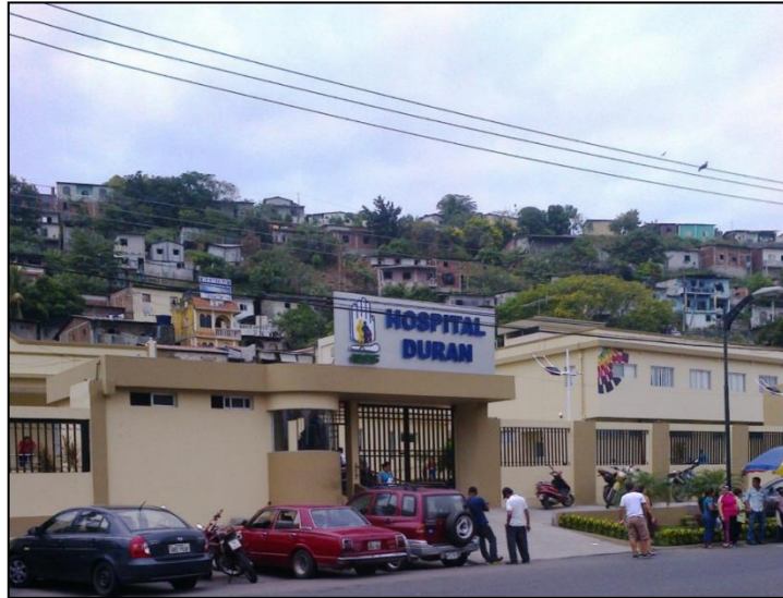
Figura 1 Infraestructura del Hospital IESS Durán
