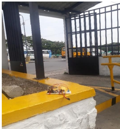
Figura 55 Prueba de envío de datos en la puerta de ingreso. Elaborado por: Zambrano Leones Tobias.
