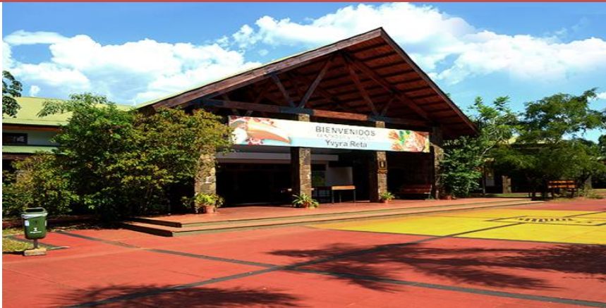
Fotografía 6. Fachada principal del centro de interpretación cultural .
