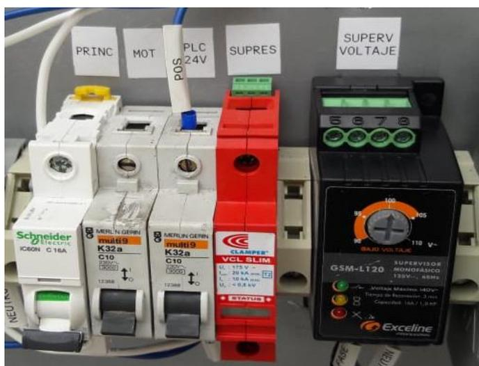
**Fuente:** Breaker – Supervisor Monofásico de Voltaje – Supresor Transiente
