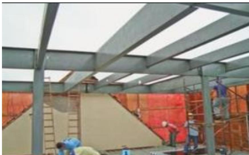
**Figura 16.** Montaje de una Estructura Metálica. Información adaptada por la Jefatura de Calidad. Elaborado por el autor.
