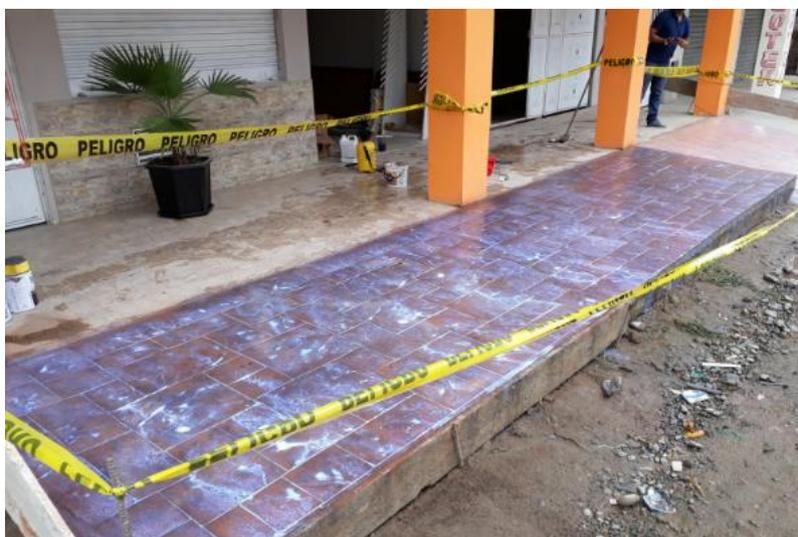
*Figura 28: Aplicación de sellador a base de agua*
