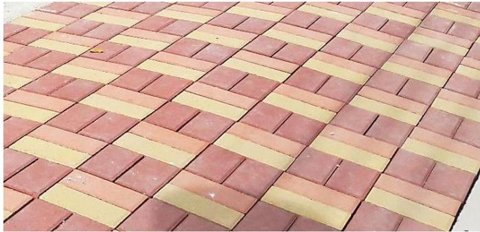
*Figura 3: Pavimento peatonal de adoquines*
