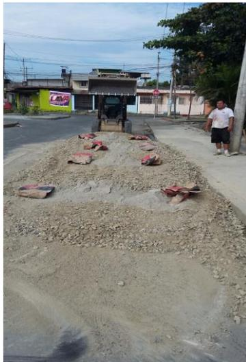
*Figura 10: Mezcla de base con cemento Portland*
