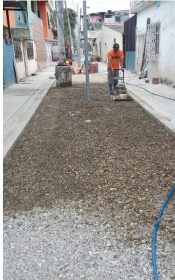
*Figura 12: Compactación de la base cementada*
