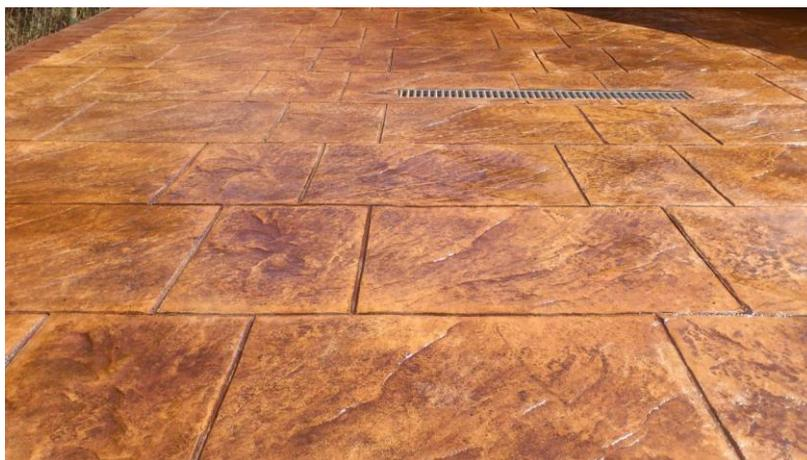
*Figura 5: Pavimento peatonal de hormigón pigmentado-estampado*
