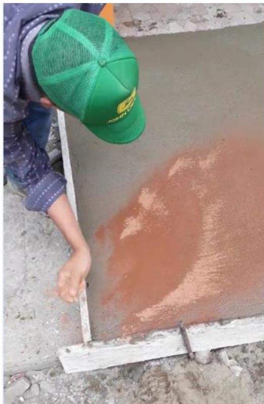
*Figura 21: Colocación de polvo endurecedor*
