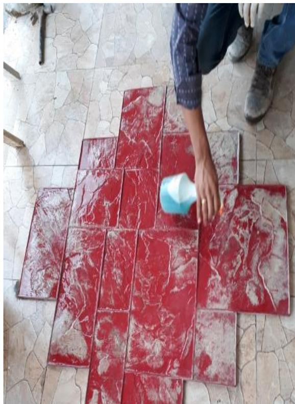
*Figura 24: Colocación de desmoldante*
