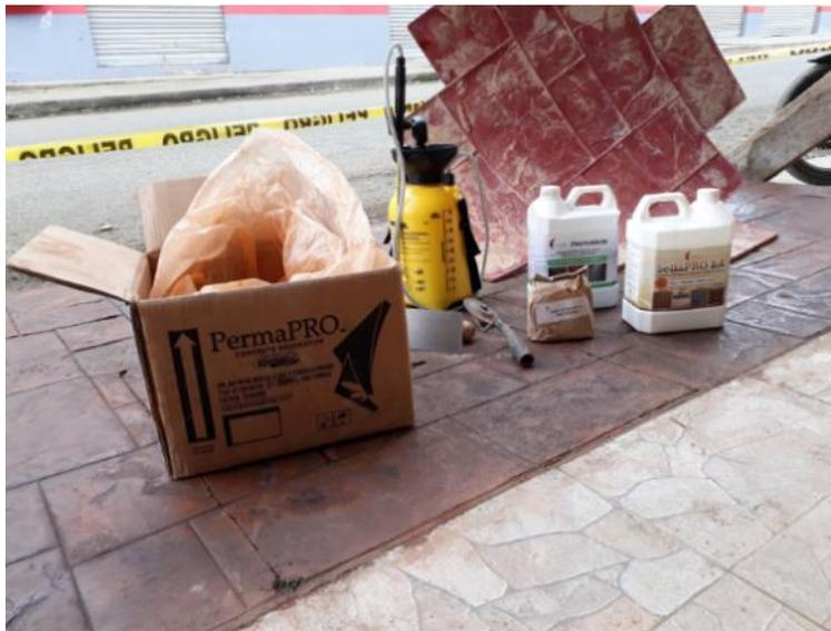
*Figura 6: Materiales para pigmentar y estampar sobre hormigón*
