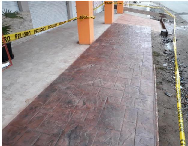
*Figura 29:* Piso de hormigón pigmentado-estampado ya terminado.
