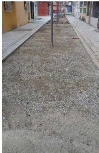
*Figura 13: Compactación de la base cementada*
