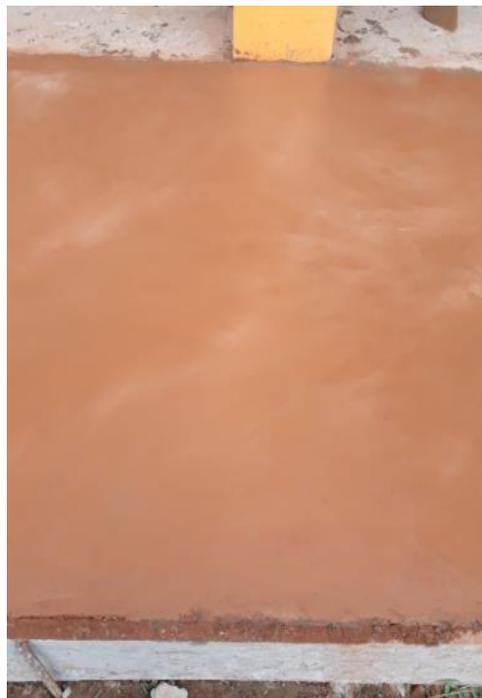
*Figura 23: Luego de aplicación de segunda capa de endurecedor*
