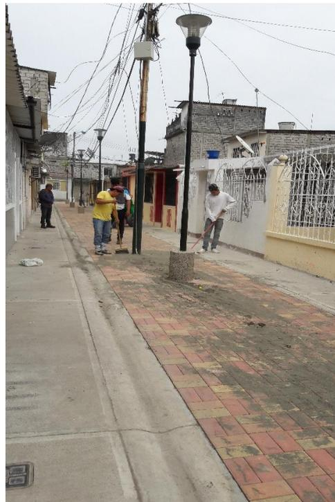
*Figura 17: Emporado de la arena fina en junta entre adoquines*
