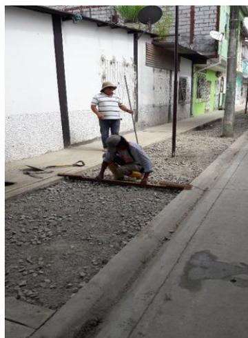
*Figura 11: Colocación de base cementada*
