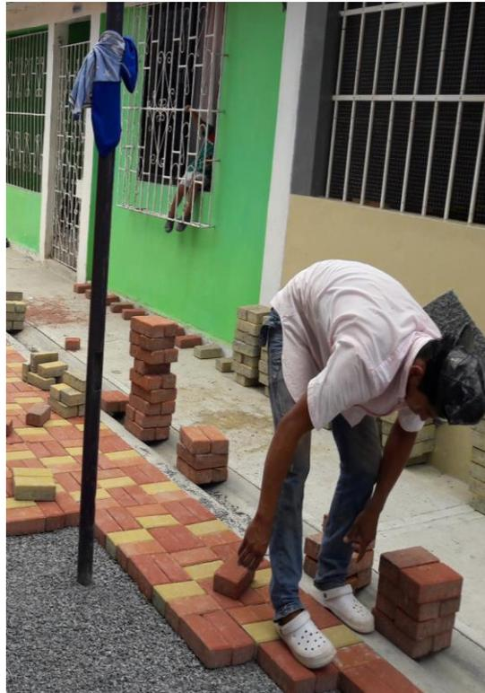
*Figura 15: Colocación de adoquines*
