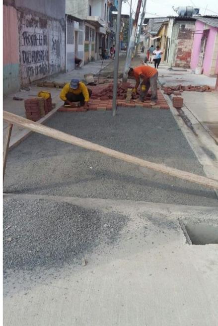
*Figura 14: Cama de cisco previo a colocación de adoquín*
