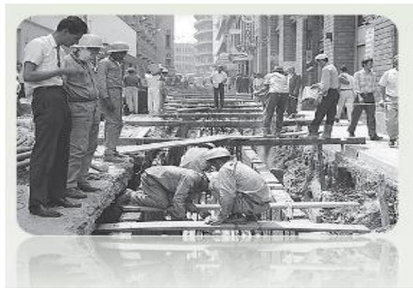
**Ilustración 11.** Construcción de un canal para drenajes de las aguas lluvias
