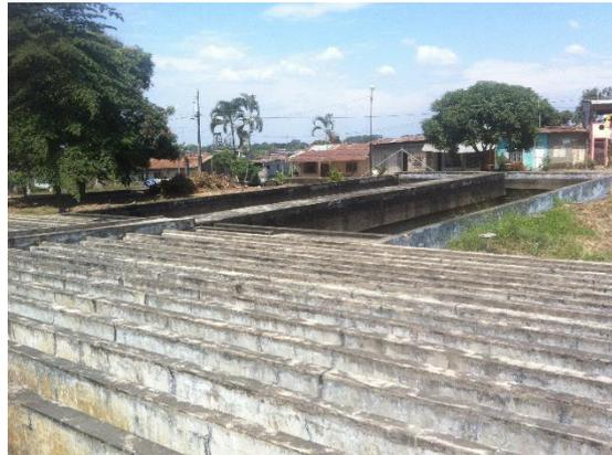
**Figura 4.** Sistema de Coagulación y Floculación
