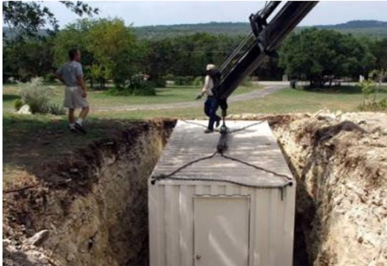
**Ilustración 13: Instalación del Contenedor Subterráneo**
