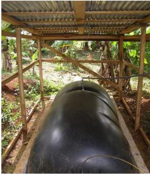
Biodigestor con cubierta
