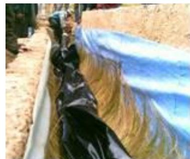
Cama y polietileno de biodigestor
