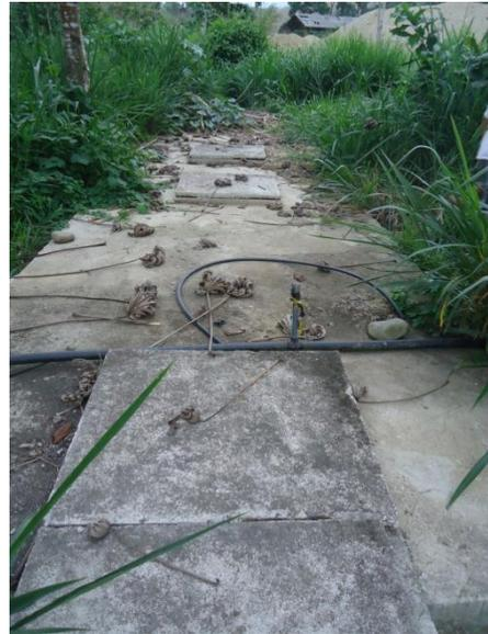
sistema de tratamiento, lo que no fue posible, pero se presume que la tubería de conducción entre la caja colectora y los pozos está colapsada. En la reunión con la comunidad, al debatir sobre el tema, una persona oriunda, indicó que la causa era la falta de mantenimiento del sistema, lo que es muy probable.
