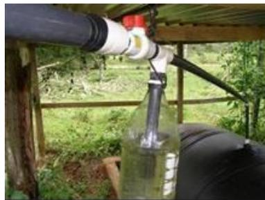
Tubería que conduce el biogás
