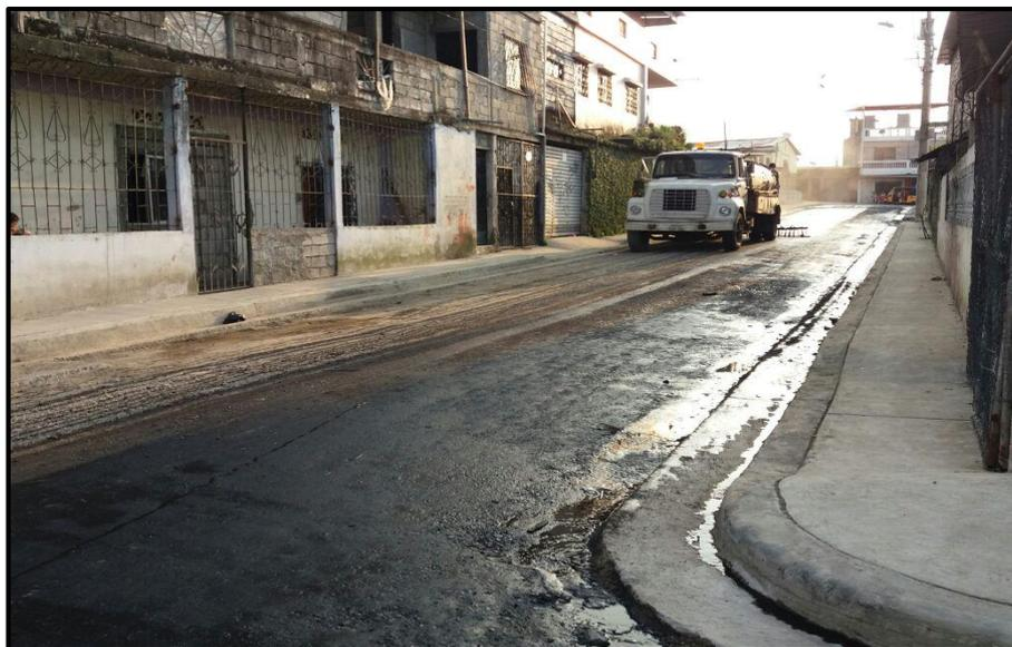
**Ilustración 5:** Imprimación de vías
