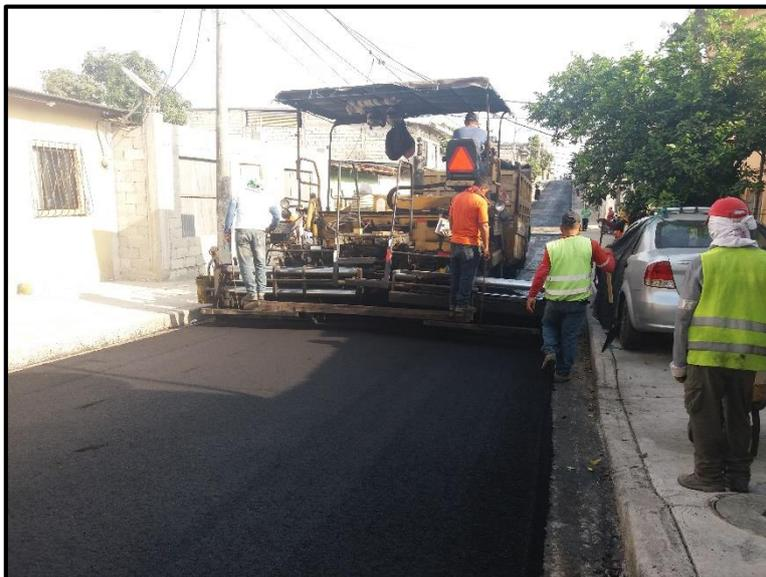
**Ilustración 8:** Colocación de asfalto
