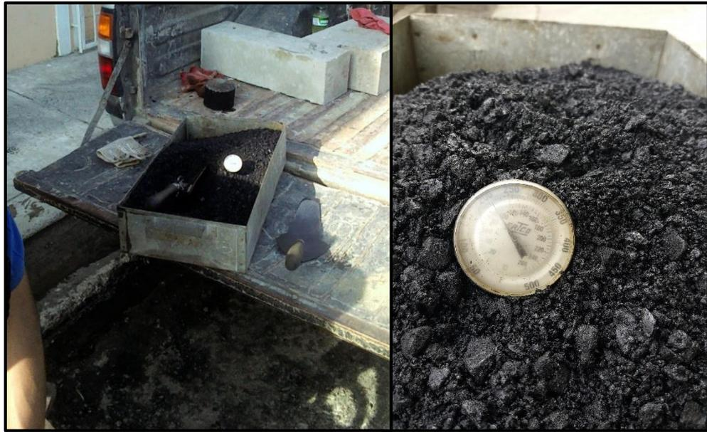
**Ilustración 58:** Control de temperatura en obra
