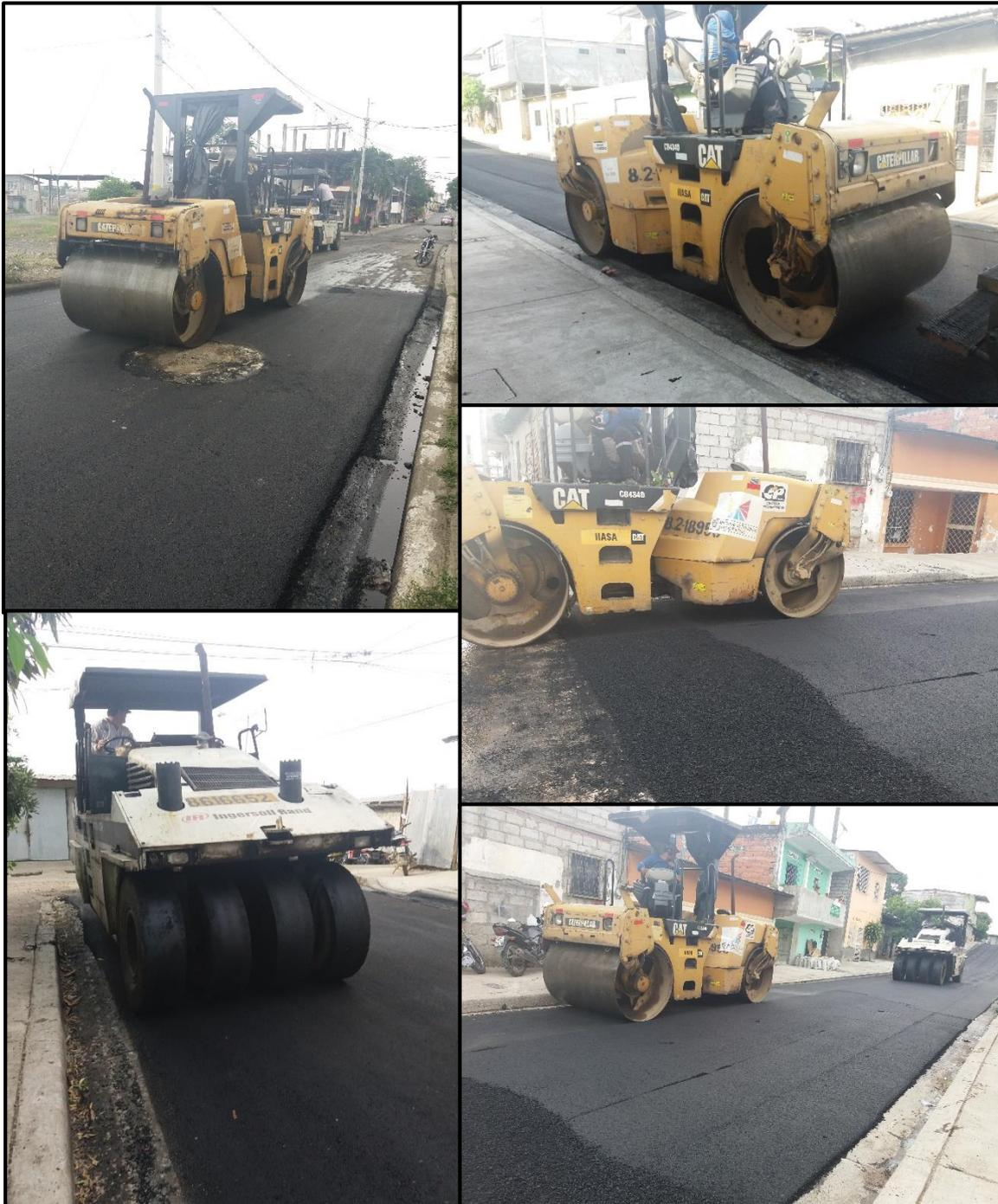
**Ilustración 73:** Compactación de la mezcla asfáltica
