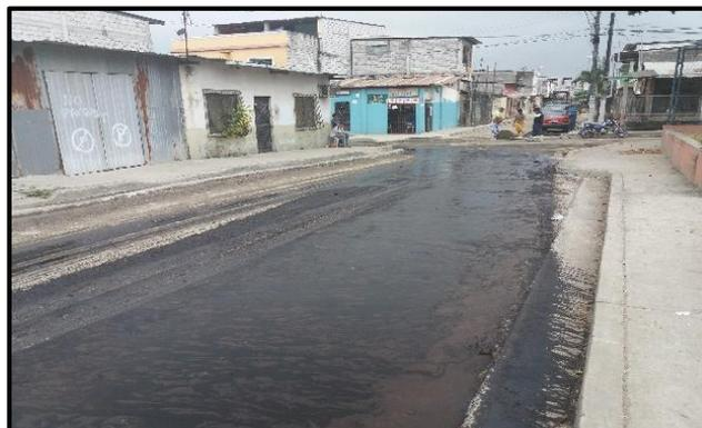
**Ilustración 69:** Exceso de Imprimación 2
