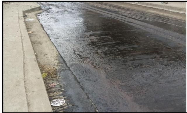
**Ilustración 68:** Exceso de imprimación 1
