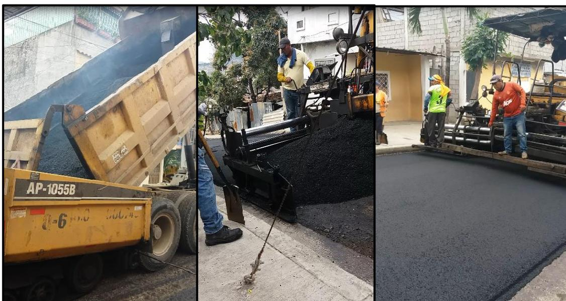
**Ilustración 72:** Mezcla asfáltica en obra
