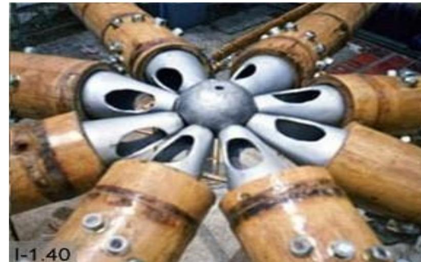
El conjunto consta de un elemento metálico central al que llega cada conexión de bambú a través de un separador esférico giratorio, que a su vez se fija mediante un anclaje conectado axialmente al bambú. Esta rotación de conectores puede dar diferentes significados a los elementos de bambú de la estructura. (Samaniego, 2018)
