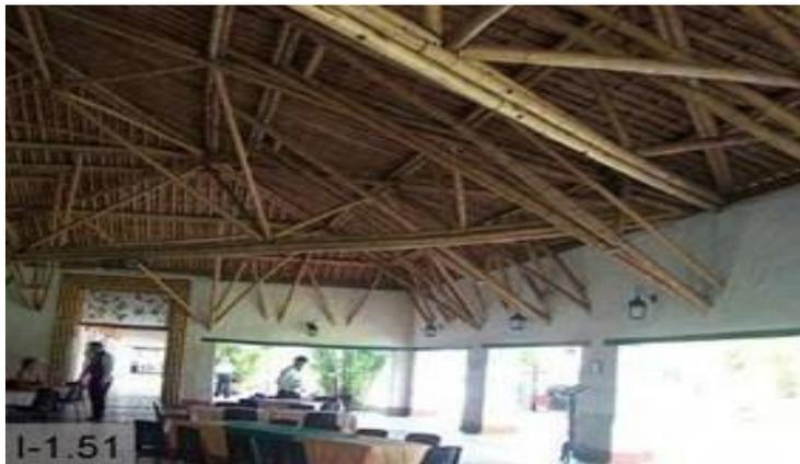
Ilustración 6 Revestimiento de estructura de caña guadua
