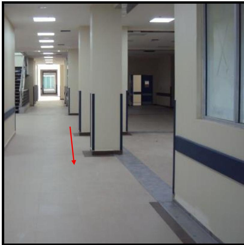
**Figura 3:** Piso recubierto de Porcelanato
