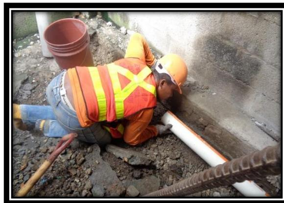
*Ilustración 5* Instalación de tubería de alcantarillado
