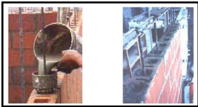
*Figura 11. Vaciado del grout.*
