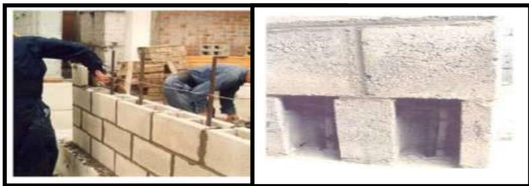
*Figura 7. Ejemplo de muro levantado y ventanas de limpieza o ratoneras.*
