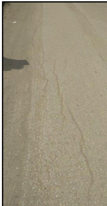
**Ilustración 23:** Grieta Longitudinal Falla Encontrada en la Calle 21.
