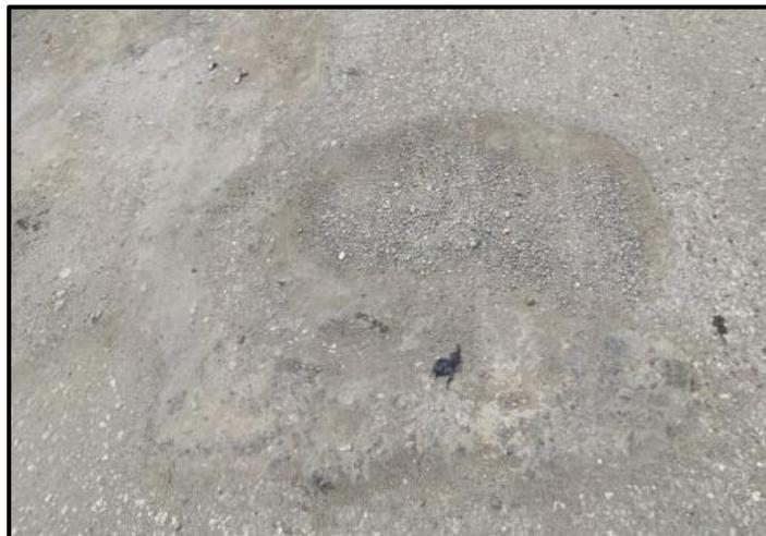
**Ilustración 21:** Abultamiento Hundimiento Falla Encontrada en la Calle 21.
