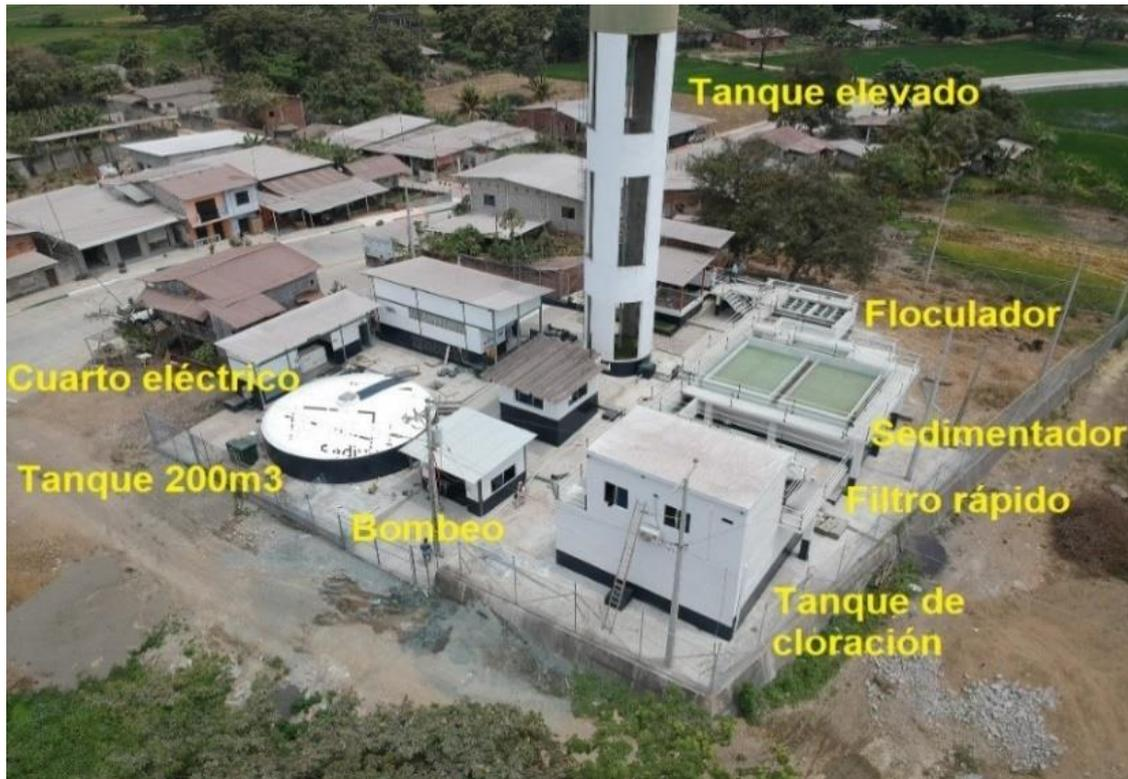
**Ilustración 7:** Foto con dron de la planta potabilizadora Laurel
