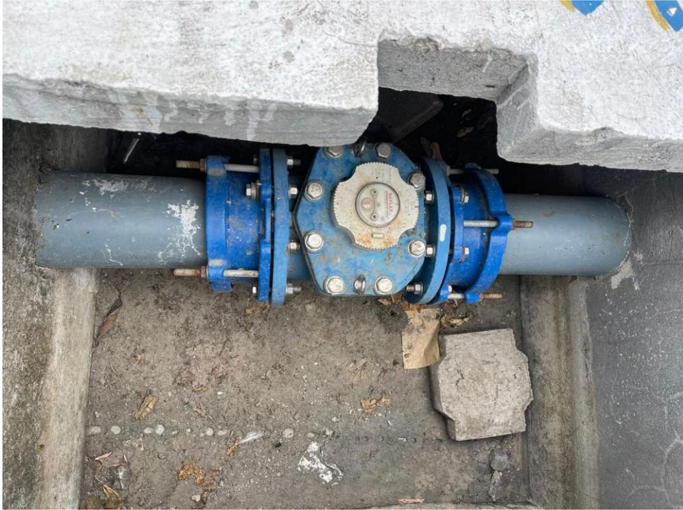
**Ilustración 23: Medidor volumetrico de agua cruda que ingresa a la PTAP**
