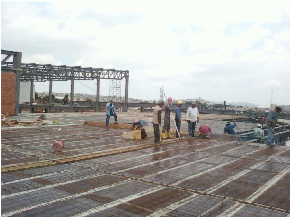
**A.3 Disposición de los nervios de hormigón**
