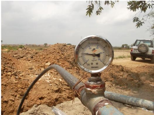
**Imagen 28** movimientos de tierra causados por la ejecución de prueba hidráulica.
