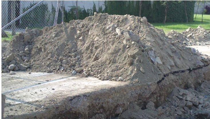
*Imagen 13 suelo almacenado cerca del sitio de la excavación pero sin las condiciones adecuadas de almacenamiento.*
