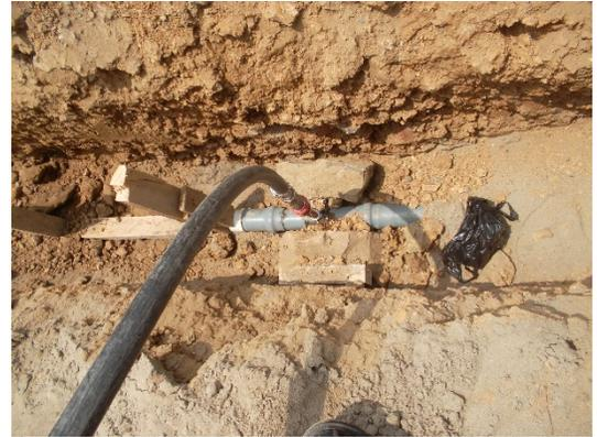
**Imagen 27** Zanjas excavadas para la realización de las pruebas hidráulicas.
