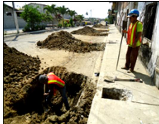
**Imagen 21** Personal realizando trabajos de excavación manual sin mascarilla para prevención del polvo.
