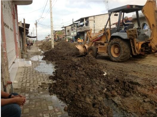
**Imagen 18** Movimiento de tierra con maquinaria.
