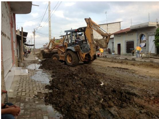
**Imagen 16** Los suelos no fueron protegidos con materiales impermeables que eviten que estos se humedezcan con las precipitaciones.
