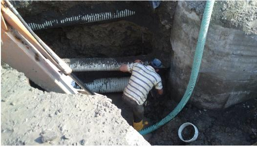
**Imagen 22 Personal sin casco en la instalación de las tuberías.**
