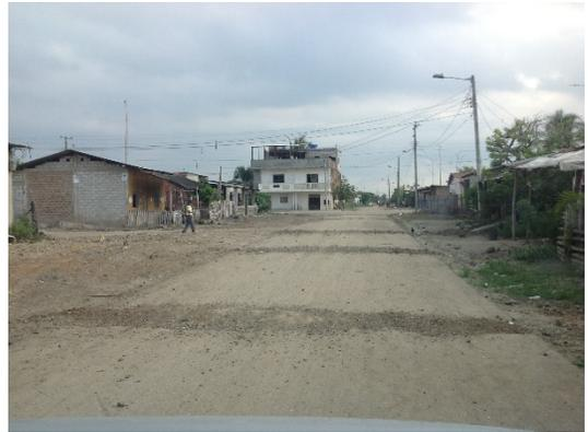
**Imagen 23 Áreas compactadas luego de la instalación de las tuberías.**
