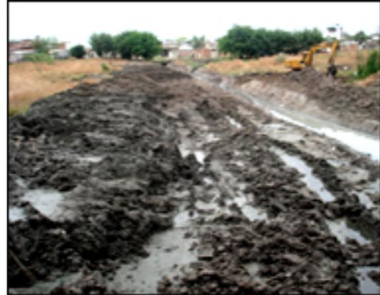
**Imagen 19** Zonas donde el terreno removido presenta gran cantidad de humedad, evitando la contaminación del aire con material particulado.
