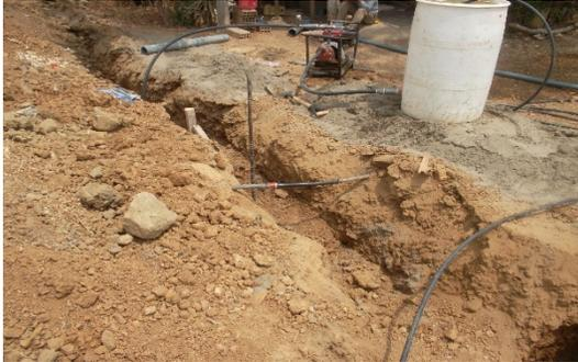
**Imagen 26** Sistema para la prueba hidráulica de la red.
