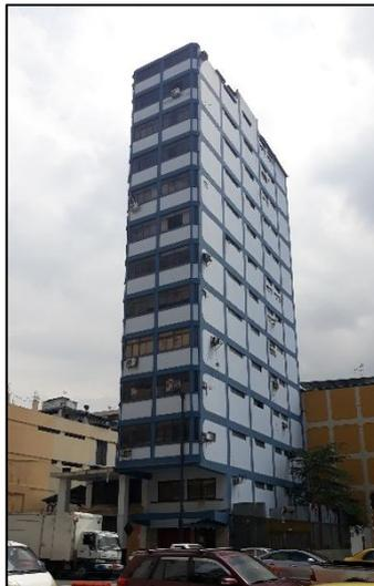
**Ilustración 19.** Edificio excesivamente esbelto.
