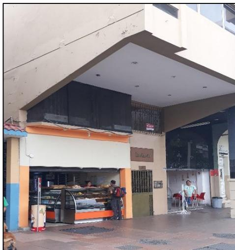
**Ilustración 16.** Edificación con ausencia de vigas altas en una dirección.
