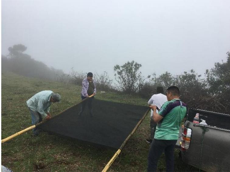
**Anexo 1** Colocación de la malla captadora a los pilares de soporte
