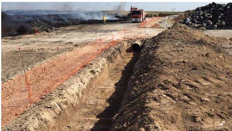
*Figura 4.* Zanja – Medio de Seguridad Técnica Pasiva.
