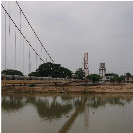
*Ilustración 3-9 - Tubería de Agua Potable
