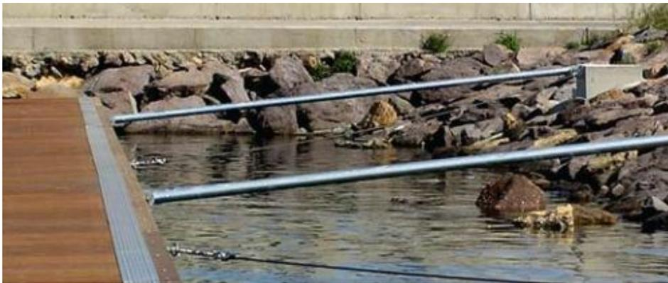
*Ilustración 2-30 - Sistema de bielas y cables tensores
