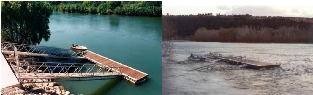
*Ilustración 2-27 - Muelle Flotante estado normal e inundado
