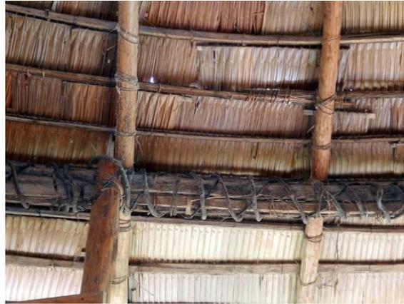
*Ilustración 2-12 - Estructura de Caña con amarres de Bejuco*
