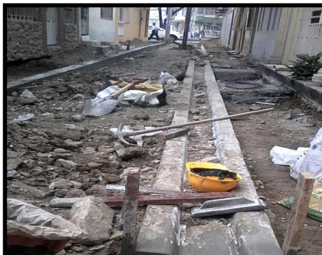
**Ilustración 2:** fundición de bordillos
