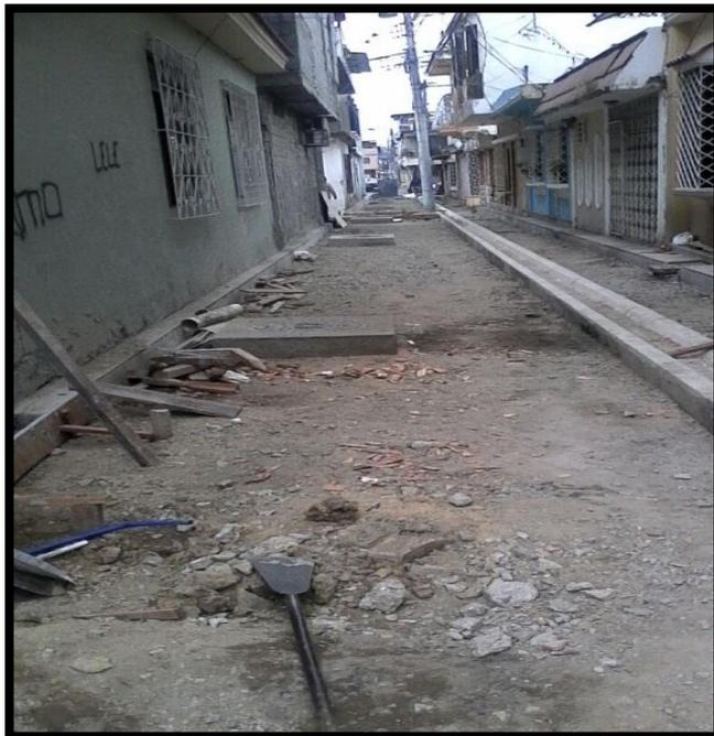
**Ilustración 3:** Desmotaje de encofrado en bordillos
