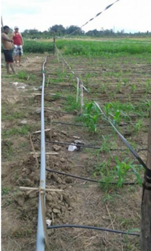
**Figura 5A.** Sistema de riego por goteo.
