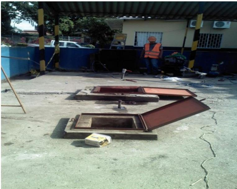
**Foto 6:** Manhole de cemento de tanques de combustible Super y Diesel
