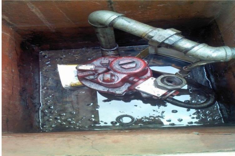
**Foto 4:** Manhole de cemento del tanque de diésel donde se aprecia la fuga de diésel de la bomba sumergible
