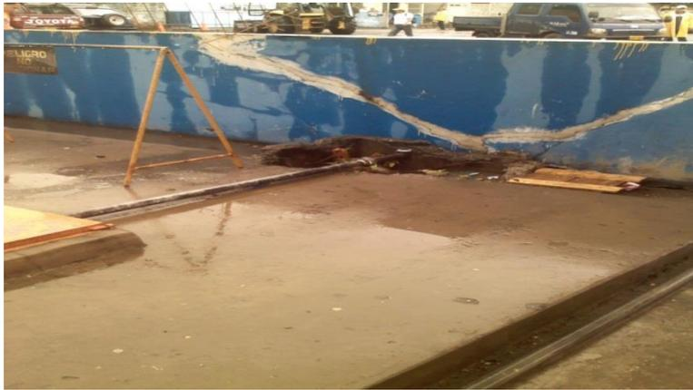
**Foto 5:** Tuberia de combustible metalica sobre el piso
