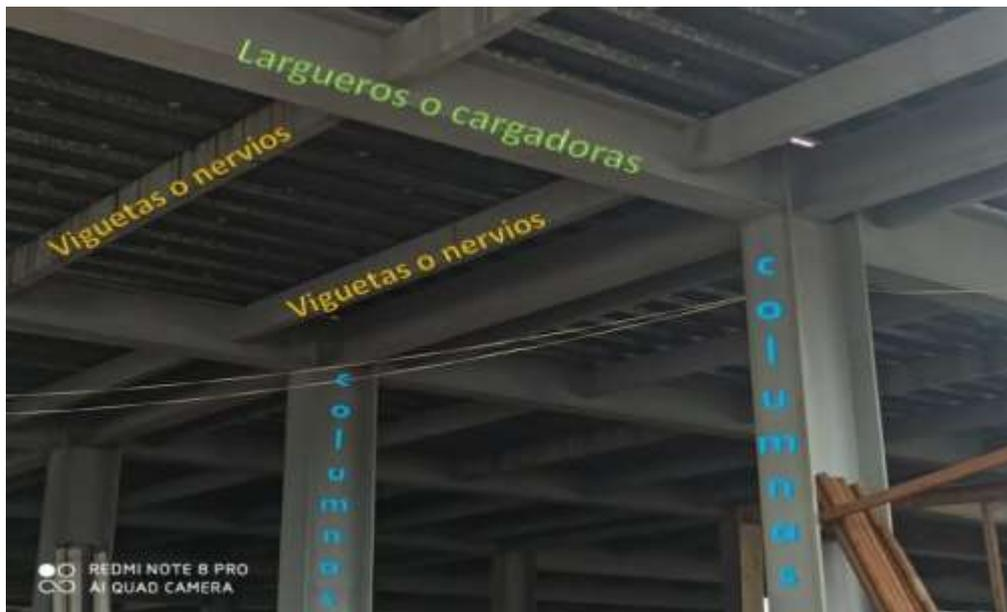
Figura 7. Estructura metálica primaria
