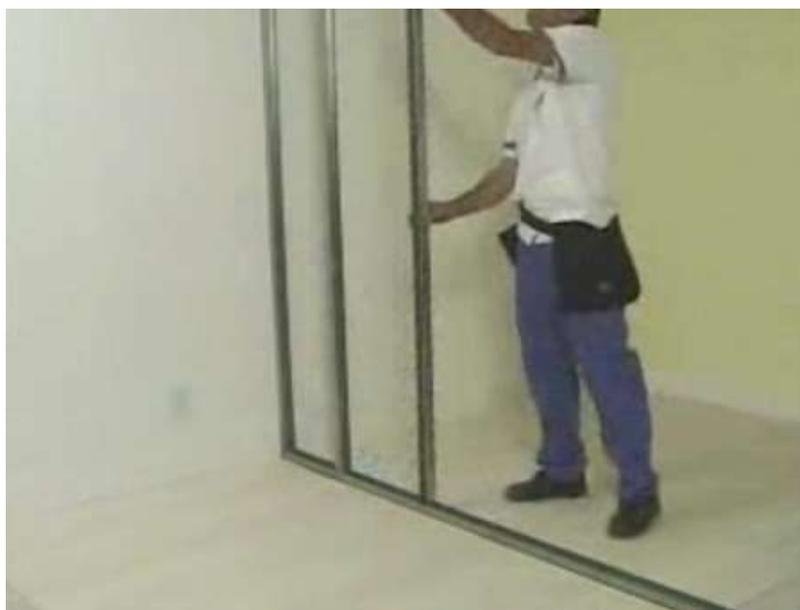
*Figura 77: Colocación de perfiles verticales
