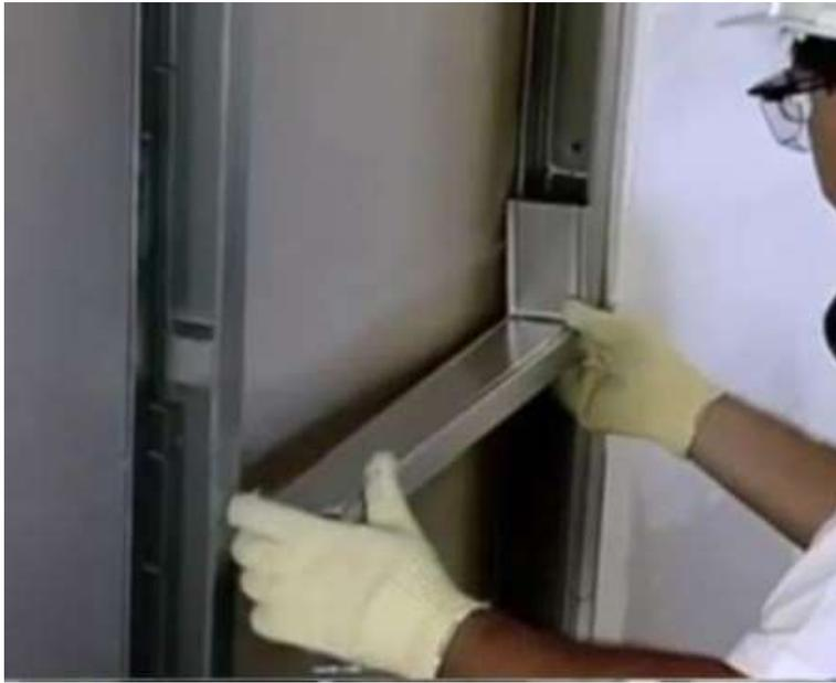
*Figura 80: instalación de rigidizadores de perfiles verticales*
