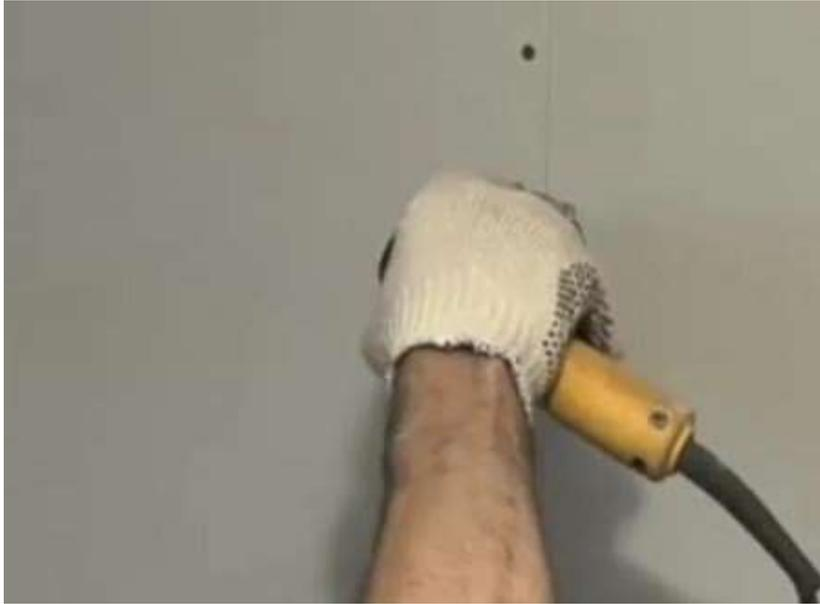
*Figura 78: fijación de la placa posterior de la pared*
