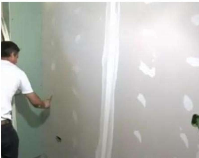
*Figura 83: Resane de juntas y perforaciones*
