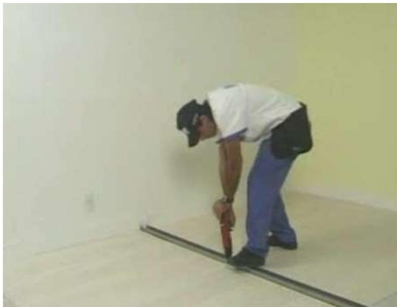
*Figura 76 fijación de rieles metálicos para paredes
