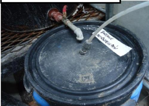
**Fotografía #26: Tanque adición solución de cloro**
