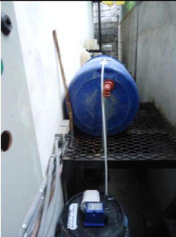
**Fotografía #16: Tanque alimentación/ floculación**
