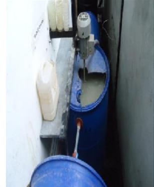
**Fotografía #18: Vista superior Tanque homgenizador**
