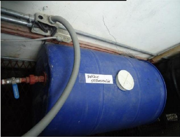
**Fotografía #20: Tanque sedimentación**
