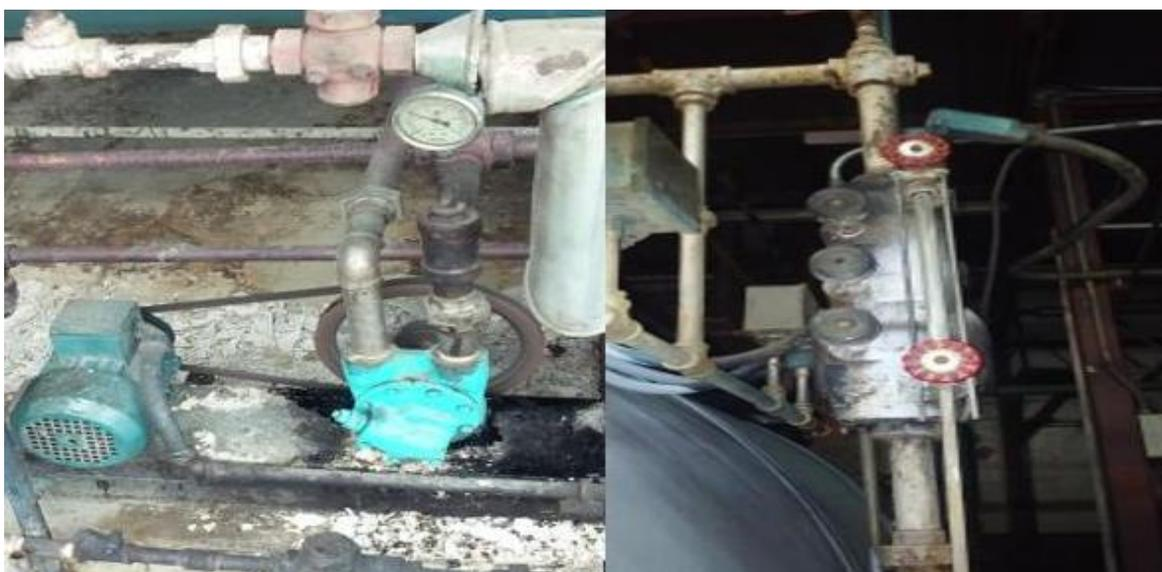
**Figura 12.** Bomba de bunker y McDonnell. Información tomada de investigación de campo. Elaborado por el autor.
