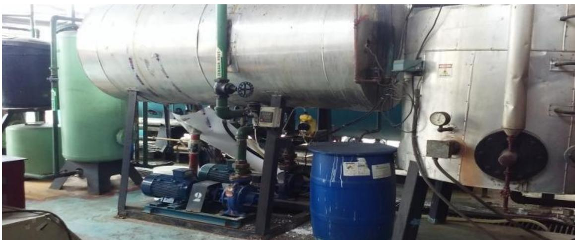
**Figura 17.** Tanque diario de alimentación de agua de la caldera. Información tomada de investigación de campo. Elaborado por el autor.
