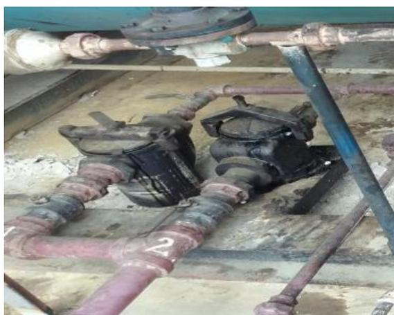
*Figura 11. Filtro de canastilla para bunker. Información tomada de investigación de campo. Elaborado por el autor.*
