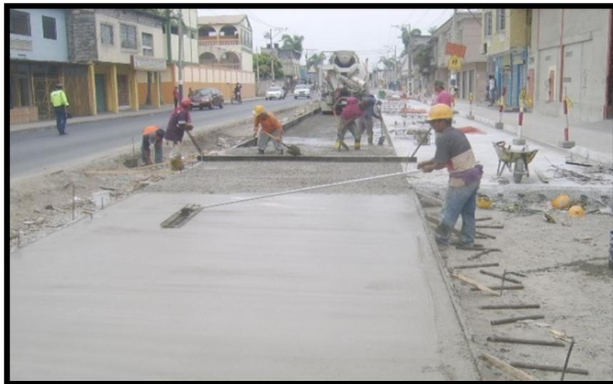
**Ilustración 30:** Alisado de la losa
