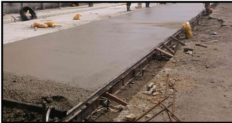
**Ilustración 23:** Colocación de pasadores en la losa
