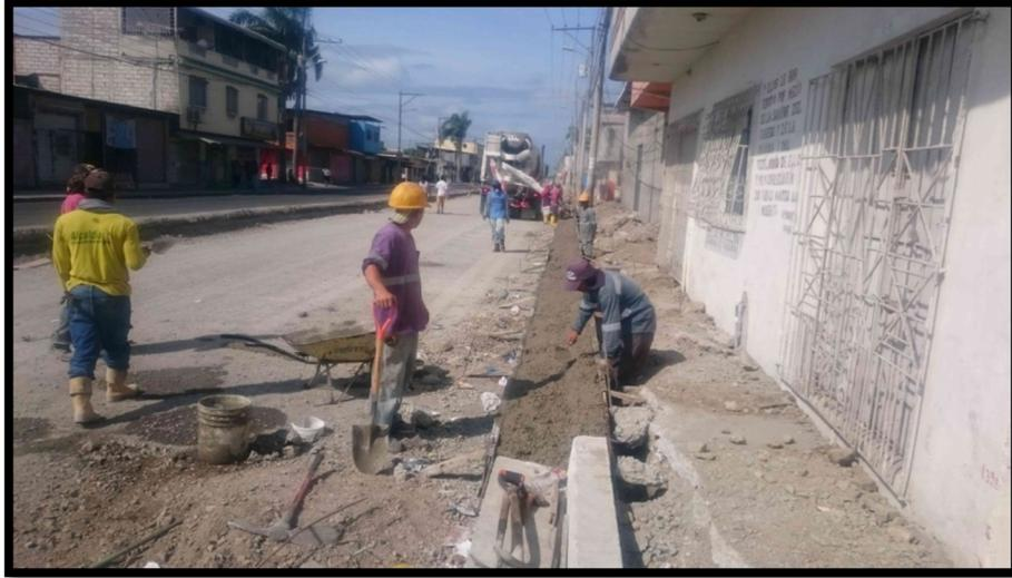
**Ilustración 12:** Hormigonado del bordillo cuneta
