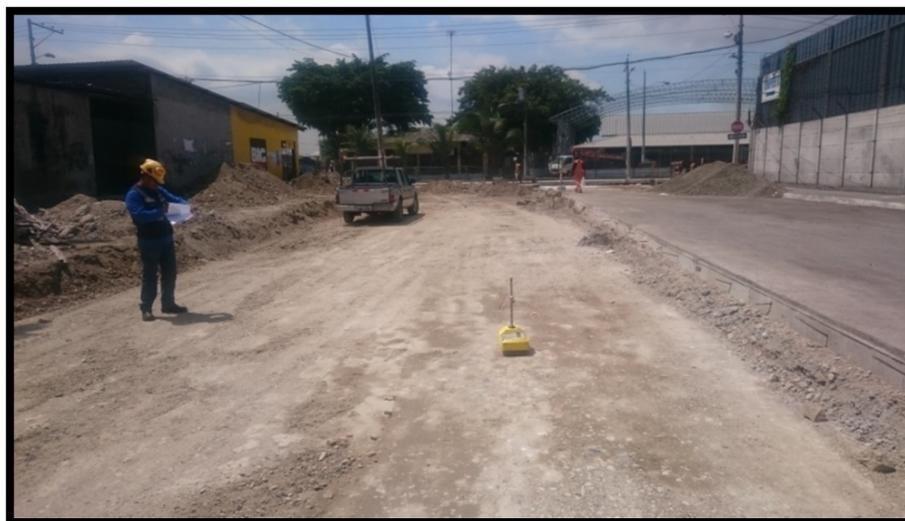
**Ilustración 18:** Toma de muestras de densidad de la compactación de la base
