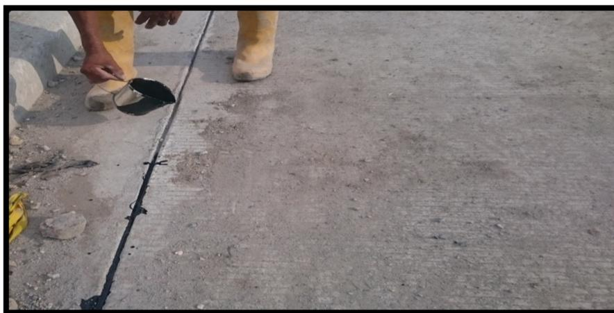
**Ilustración 31:** Sellado de juntas con mezcla bituminosa
