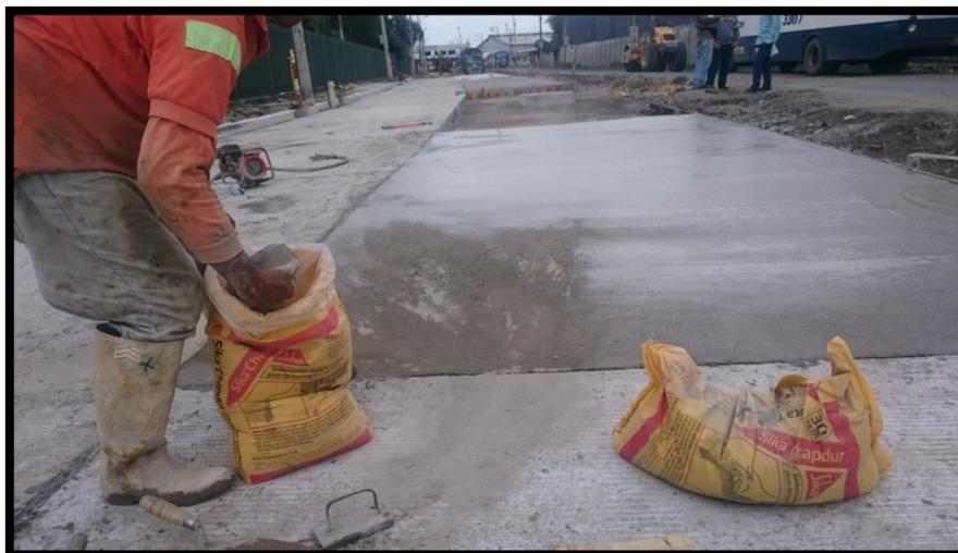
**Ilustración 32:** Curado de la losa
