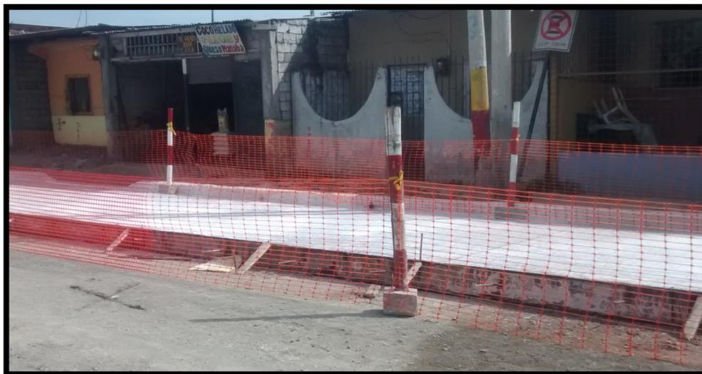
**Ilustración 33:** Protección del pavimento
