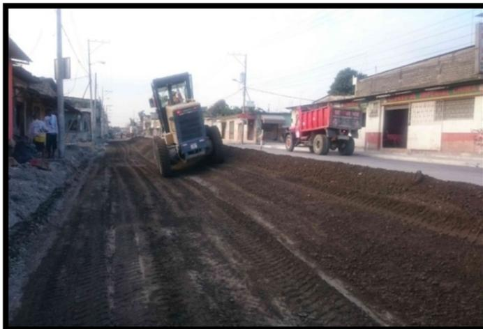
**Ilustración 15:** Tendido de la capa de base estabilizada
