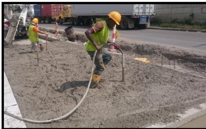
**Ilustración 28:** Vibrado del hormigón fresco
