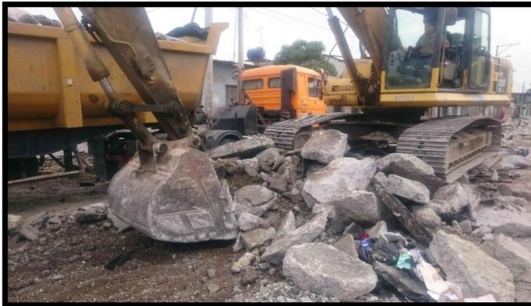
**Ilustración 8:** Excavación del pavimento existente
