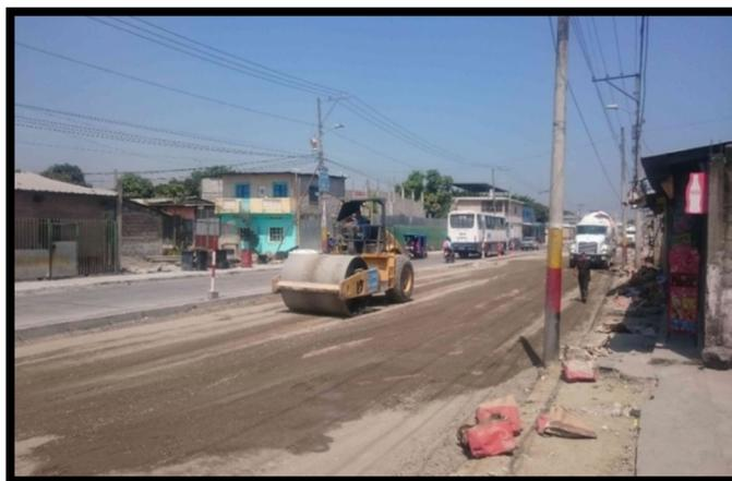
**Ilustración 16:** Compactación de la base estabilizada
