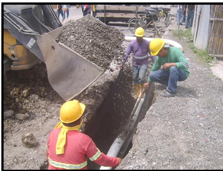
**Ilustración 10:** Colocación de la piedra triturada al subdren
