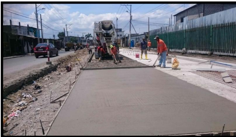
**Ilustración 29:** Enrasado de la losa
