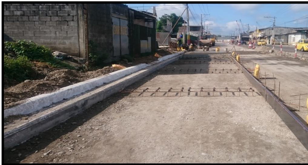
**Ilustración 21:** Colocación de los dowells
