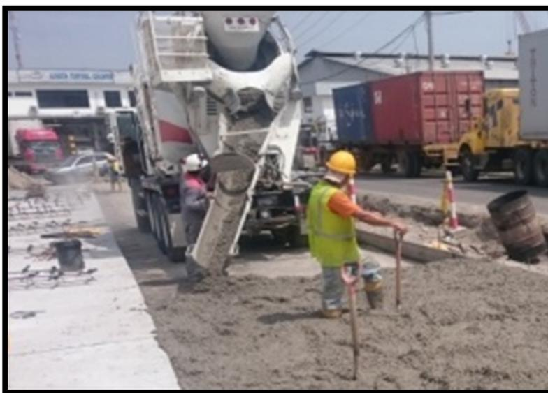
**Ilustración 24:** Vaciado del hormigón.
