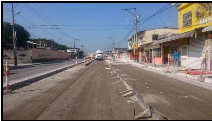
**Ilustración 19:** Colocación y enclavamiento de los moldes de encofrado
