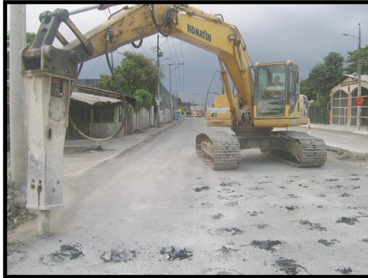
**Ilustración 7:** Demolición del pavimento existente
