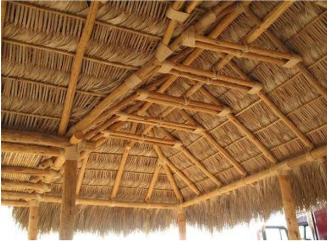
*Uso de la hoja de palma para las cubiertas de los conjuntos y techados*
