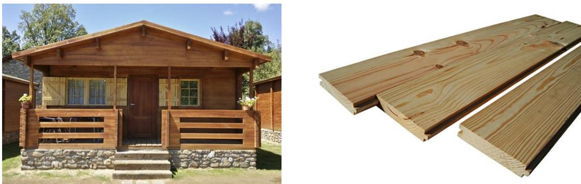
*Uso de paneles en madera machihembrada para paredes de los conjuntos.*
