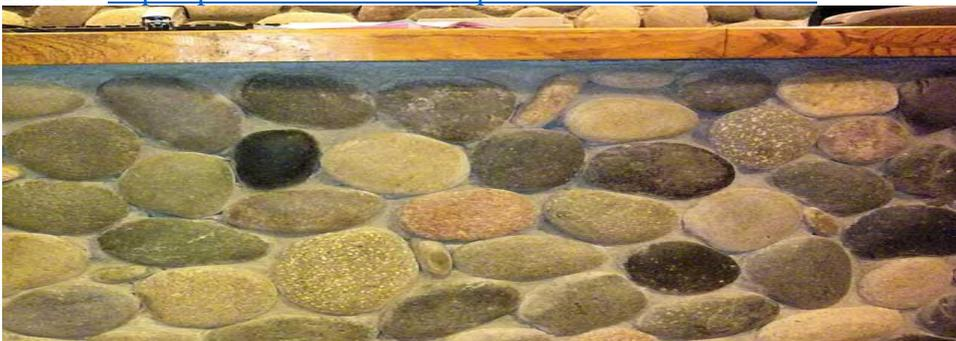
*Piedra bola extraída de río para recubrimientos de muros de jardineras.*
