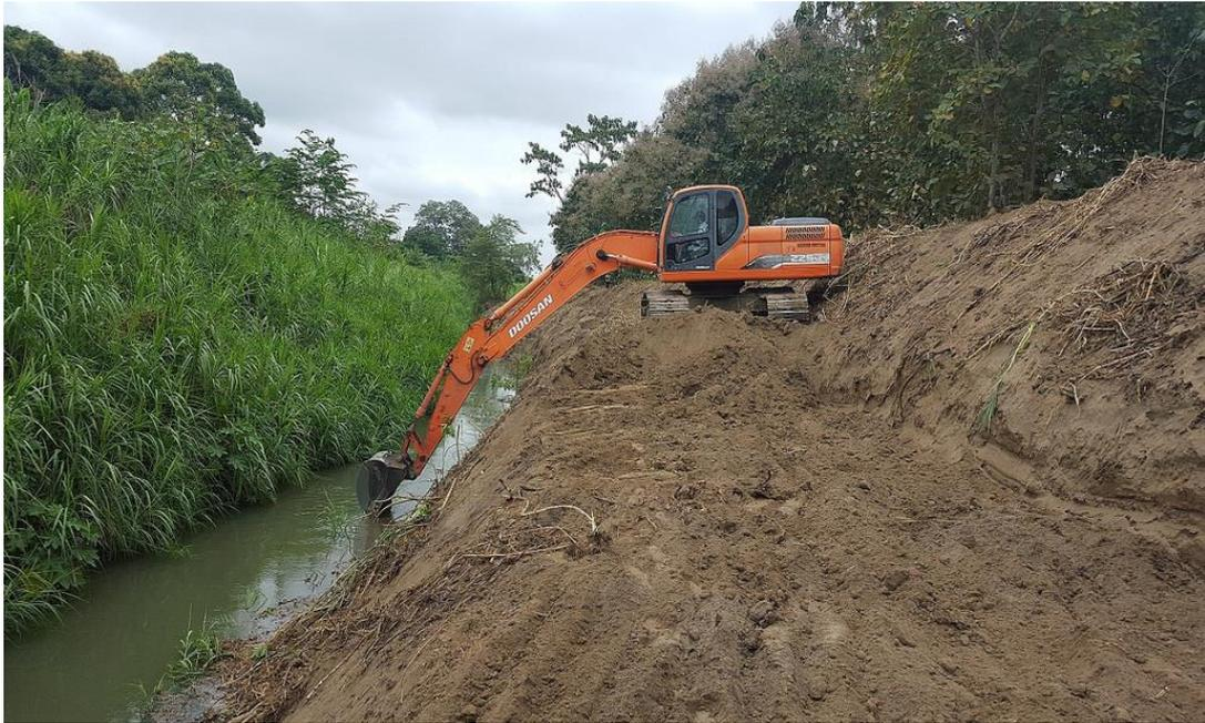
**Figura # 3: Extracción mecánica de arcilla en el Estero Belín**
