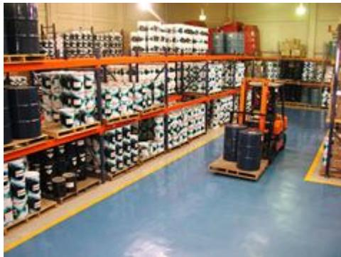
Las pinturas epoxicas ofrecen soluciones para una amplia variedad de problemas que se pueden presentar en la protección de los pisos. Los recubrimientos Epoxicos y de Poliuretano son los mas apropiados, por que ellos combinan una gran resistencia a la alcalinidad del concreto, con la capacidad de ser formulados para resistir las diferentes condiciones a que se pueden enfrentar los pisos industriales.
