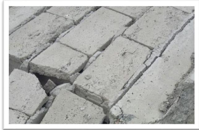
*Ilustración 1: Fisuramiento de mortero, y desprendimiento.*
