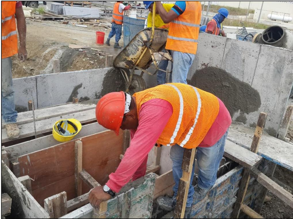
**Anexo fotográfico 4.- Colocación de soportes de bombas sumergibles.**
