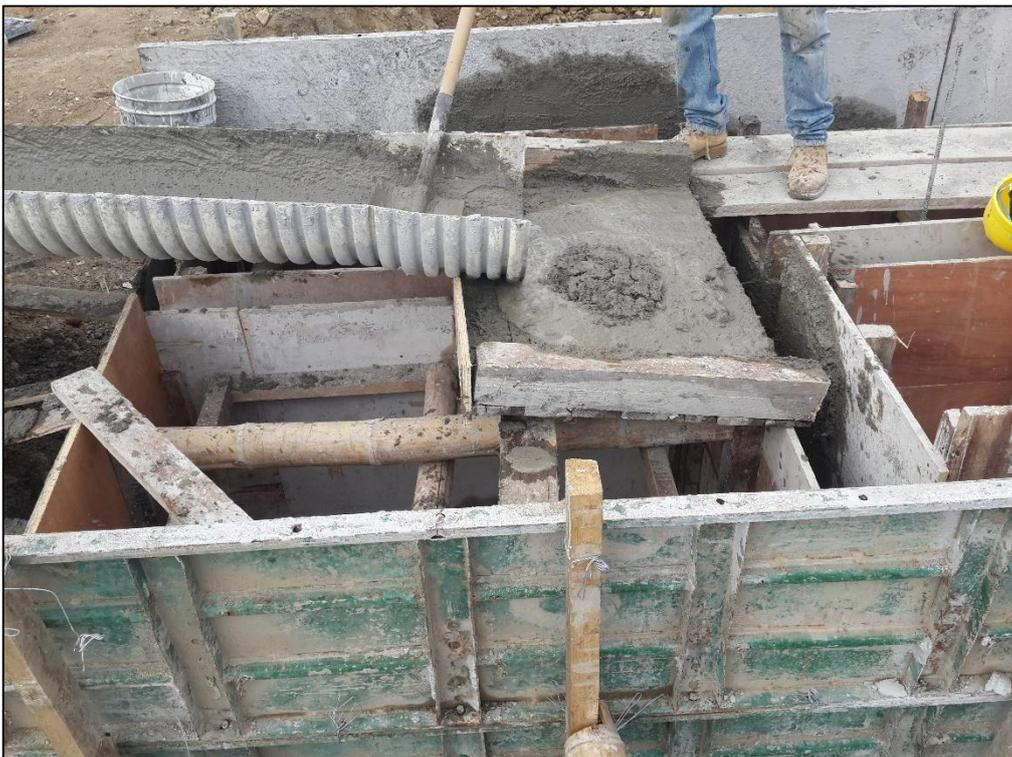
**Anexo fotográfico 3.- Vibrado de concreto vertido.**
