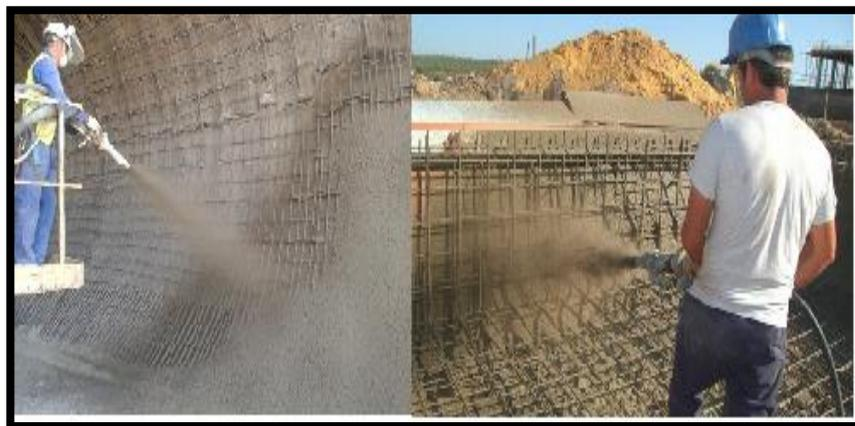
*Ilustración 5: Hormigón proyectado*
