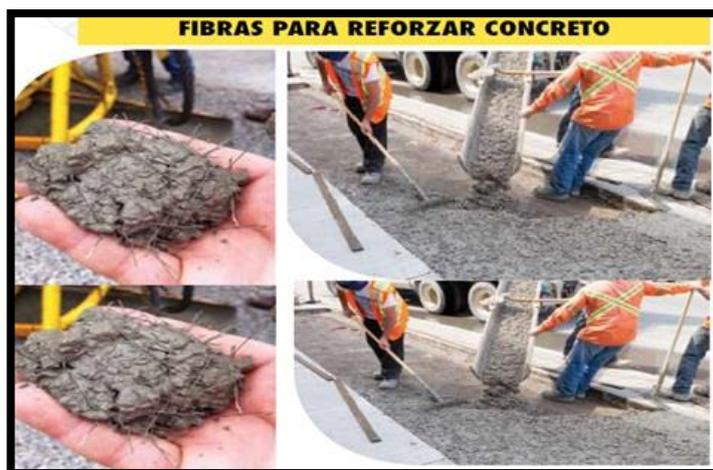
*Ilustración 4: Pavimentos de hormigón reforzado con fibras de acero*
