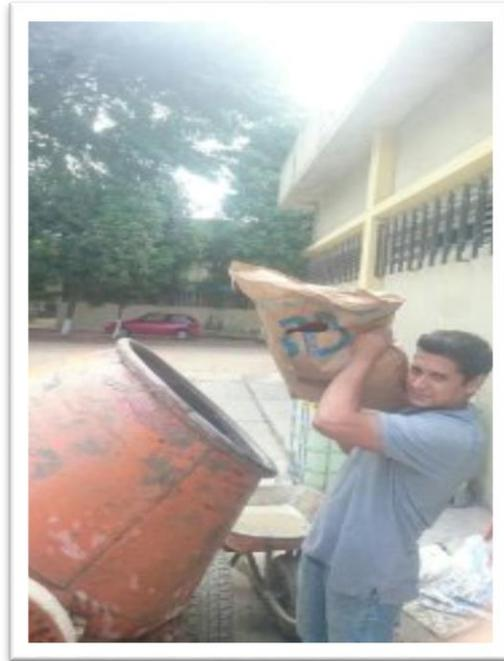
Fotografía 9: Elaboración de hormigón con Dramix
