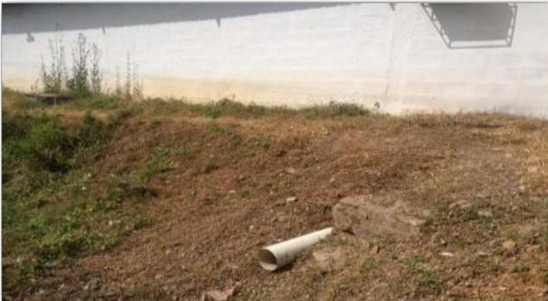
Figura 31: Desembocadura de Aguas Residuales al canal Perimetral
