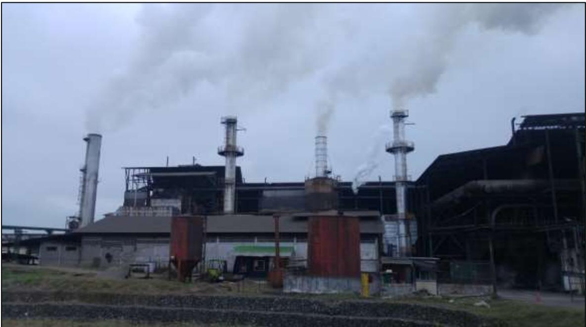
Figura 35. Fuentes fijas de combustión con lavadoras de gases.
