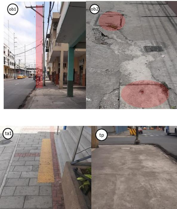
*Nota:* primera fila obstáculos (postes de luz y tapas de alcantarilla en mal estado), segunda fila textura de adoquín y textura de hormigón. Fuente: *Autores*
