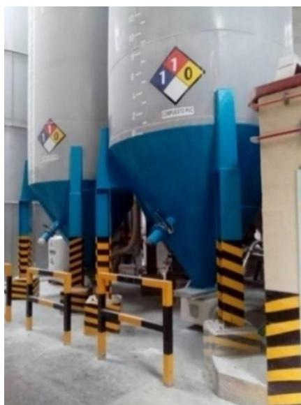
**Figura 4.** Silos para el almacenamiento para la materia prima y materiales aditivos. Información tomada de Mexichem Ecuador S.A., Elaborado por el autor.
