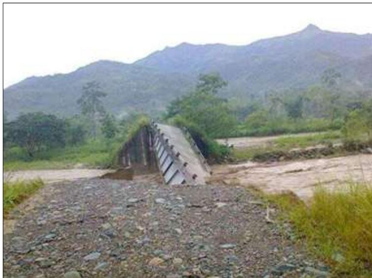
**Ilustración 3:** Muestra una vista fotográfica del colapso del puente en el momento del desborde del Rio Changuil.
