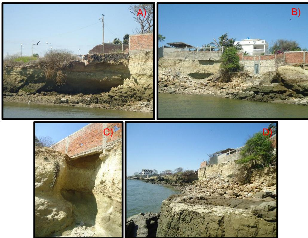
Foto 6.1. Imágenes A, B, C y C en la que se puede observar la infraestructura afectada por la variación de la desembocadura del río Data de Posorja. Fuente: Autor
