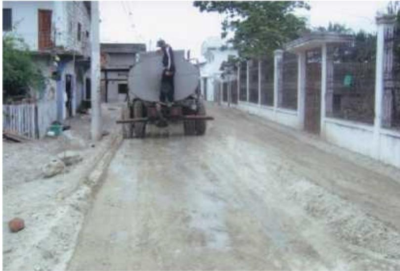
ANEXO 4 :PERSONAL DE LA EMPRESA SUBIDO EN LA PARTE POSTERIOR DEL TANQUERO QUE ESTA HIDRATANDO UNA CALLE, SIN EL EQUIPO DE PROTECCIÓN PARA SU SEGURIDAD, ESTE ERROR NO SE DEBE COMETER, ES UN RIESGO LABORAL.
