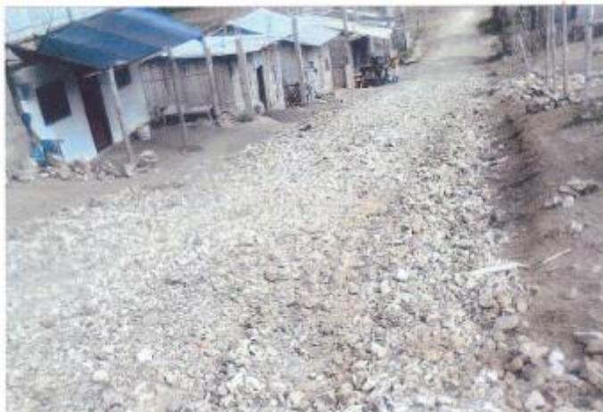
EJEMPLO DE MATERIAL REGADO EN LAS CALLES SIN LA APLICACIÓN DE LAS NORMAS, COMPACTACIÓN DE MATERIAL EN MAL ESTADO
