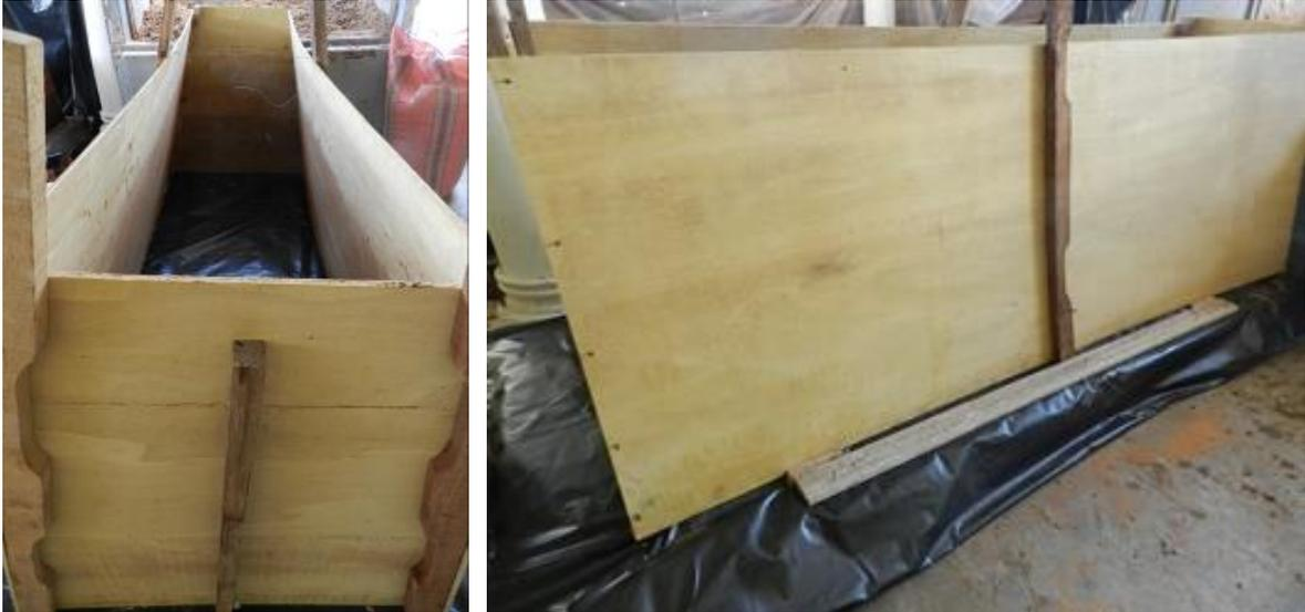
**Figura No. 3.3: Molde empleado para el montaje de las pilas.**
