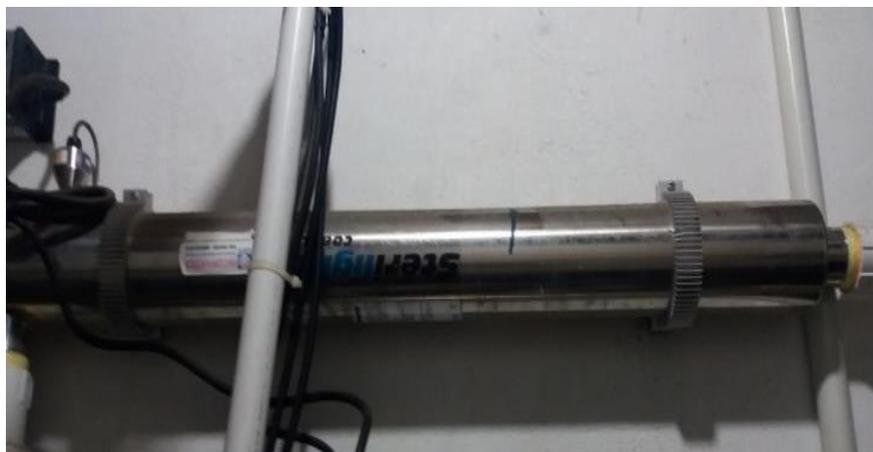
**Figura 9.** Lámpara UV. Información tomada de la Empresa. Elaborado por el autor.
