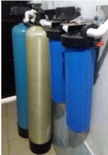
**Figura 8.** Filtro de Carbón Activado. Información tomada de la Empresa. Elaborado por el autor.
