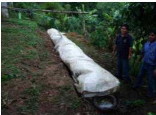
**Figura 19.** Biodigestor tubular plástico instalado en Imbabura. Información tomada de climate technology centre network (CTCN). Elaborado por CTCN.
