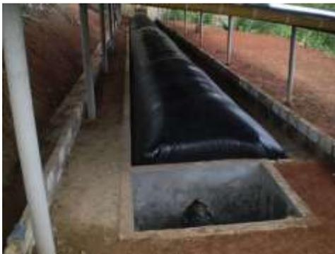
**Figura 15.** Biodigestor simple de flujo discontinuo. Información tomada de DisAmbiental. Elaborado por DisAmbiental.
