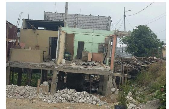
Cabe destacar que la mayoría de las viviendas colapsadas el 16 de abril han sido construidas en hormigón armado en la ribera de la Cooperativa. Debido a su peso y a la falta de estudio estructural, muchas casas se hundieron o sus pisos colapsaron con el movimiento sísmico.
