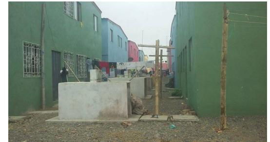
El programa contempla la construcción de viviendas multifamiliares en 51 bloques, de cuatro departamentos cada uno; dos en la planta alta y dos en la planta baja. La estructura es de hormigón armado, con losa entrepiso, cubierta metálica pre pintada y cielo raso, ventanas de aluminio y vidrio. Cada departamento tiene un área de 40 metros cuadrados distribuido en sala, comedor, cocina, 2 dormitorios y 1 baño
