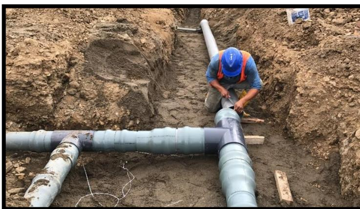
***Fig. # 49. Tubería PVC Presión de 90 mm***
