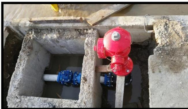
**Fig. # 56. Instalación de Hidrante**
