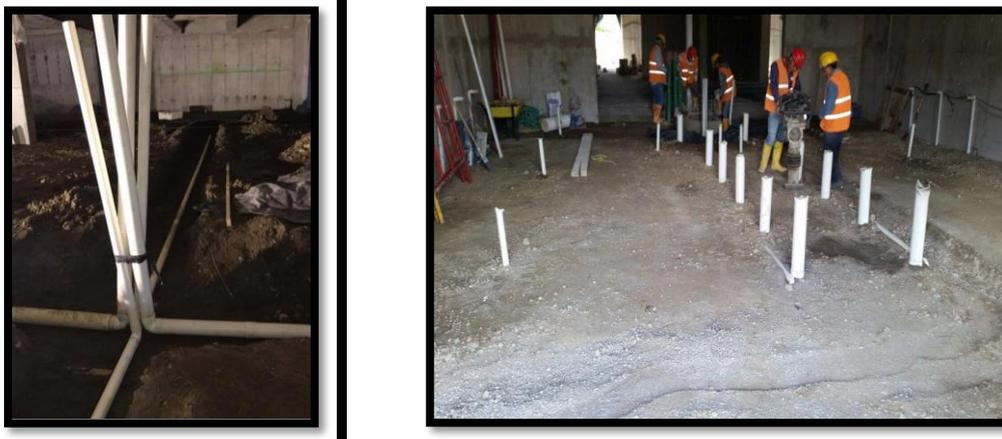
**Fig. # 43. Proceso de Pegado de las Tuberías de PVC**
