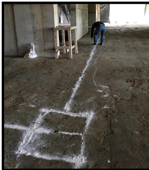
**Fig. # 36. Replanteo para la instalación de tuberías**
