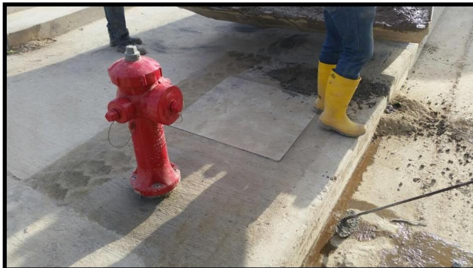
***Fig. # 57. Instalación de Hidrante***
