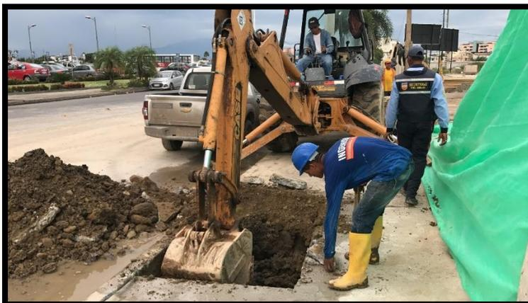
**Fig. # 55. Excavación para Instalación de Hidrante**
