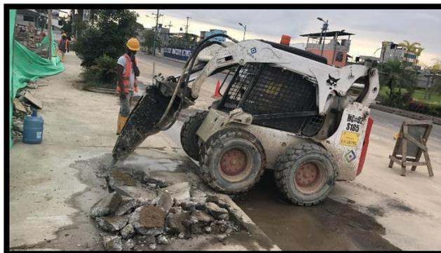
**Fig. # 54. Rotura de Hormigón**
