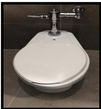
**Fig. # 45. Inodoros con Fluxómetro**
