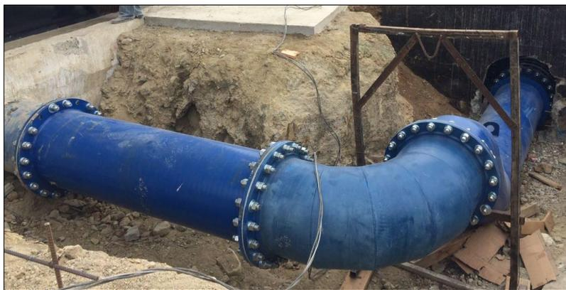
**Figura 10:** Tee de acero bridado  $\varnothing 400\text{mm}$
