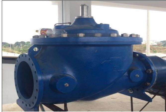
**Figura 22:** Válvula de altitud
