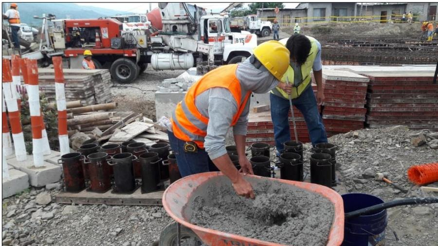
**Figura 41:** Recolección de muestras de hormigón para resistencia.
