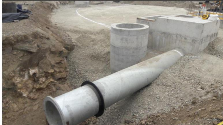
**Figura 30:** Colocación de relleno alrededor de las estructuras.
