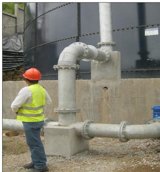
**Figura 46:** Bloques de anclaje para tuberías.
