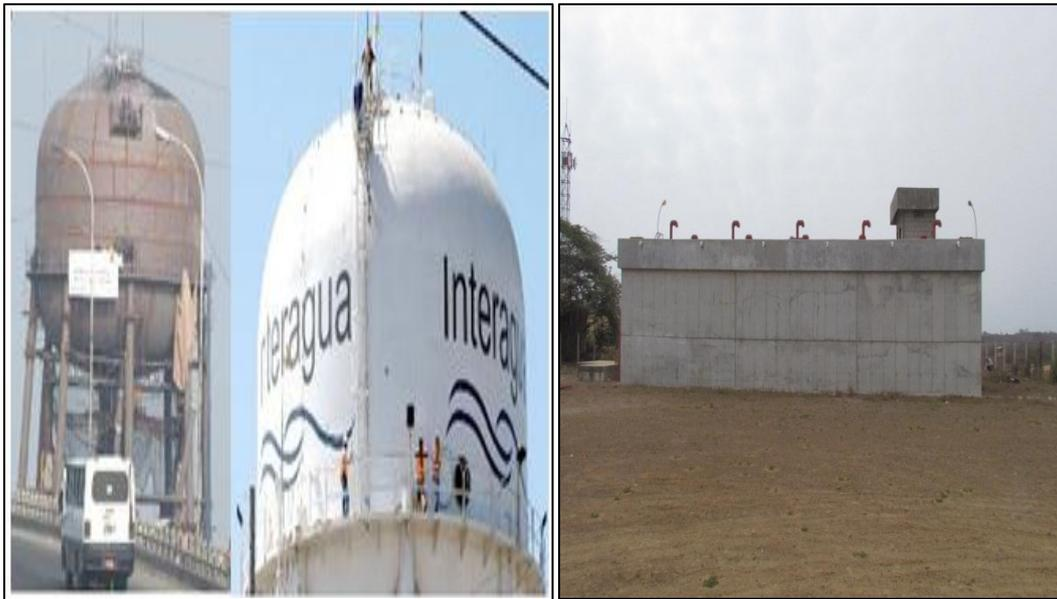
**Figura 6:** Reservorio soldado en la Isla Trinitaria (Interagua); Reservorio de hormigón armado existente en Posorja (Hidroplayas).
