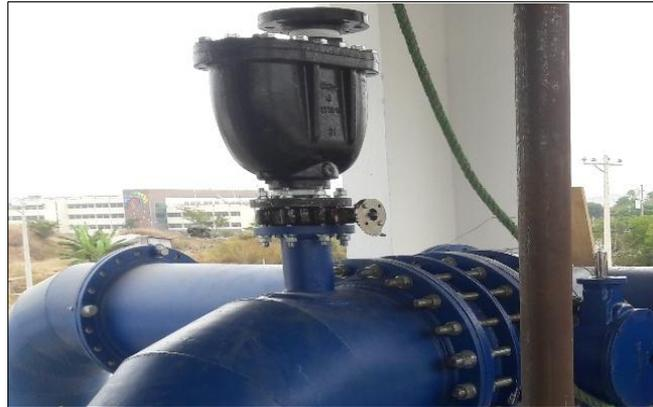
**Figura 19:** Válvula de aire
