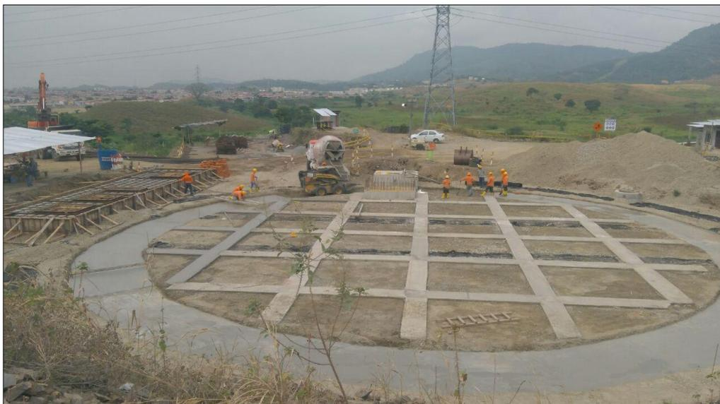
**Figura 33:** Replanteo para la cimentación del reservorio
