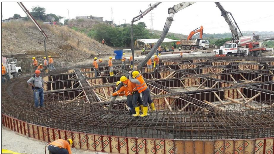
**Figura 39:** Colocación del hormigón pre-mezclado.
