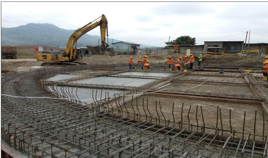
**Figura 37:** Armadura para la cimentación del reservorio
