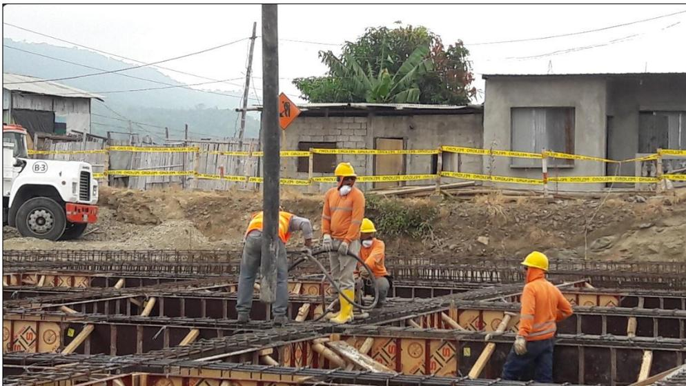
**Figura 44:** Vibración del hormigón.
