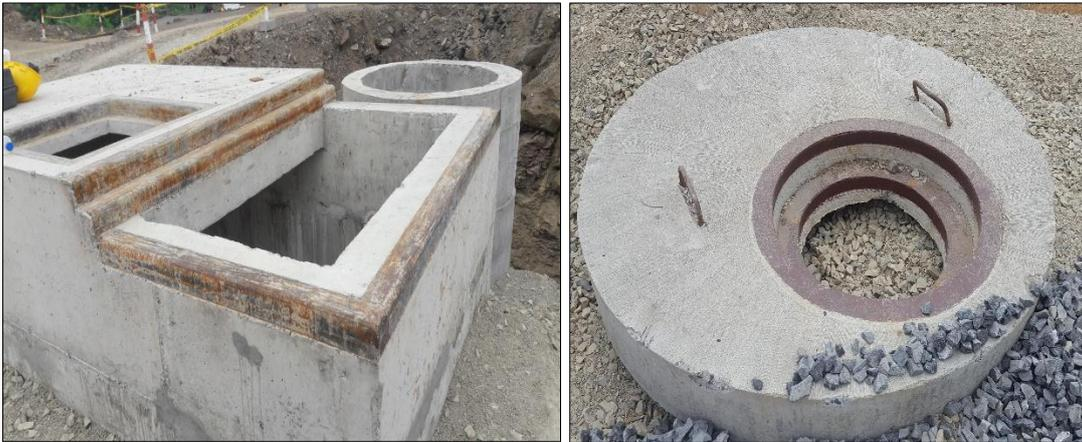
**Figura 47:** Instalación de perfiles metálicos.
