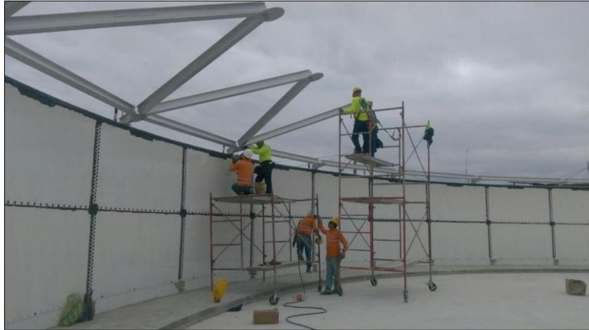
**Figura 65:** Construcción del domo de aluminio.
