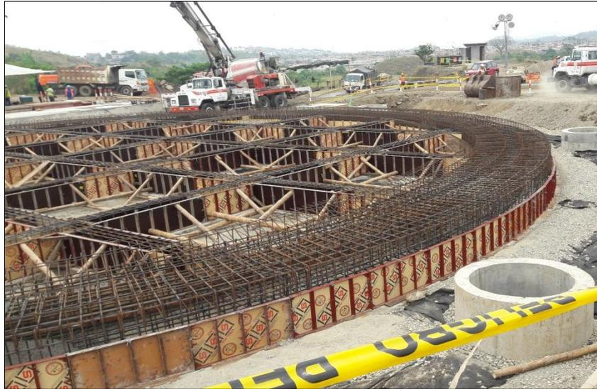
**Figura 38:** Viga para la cimentación del reservorio.
