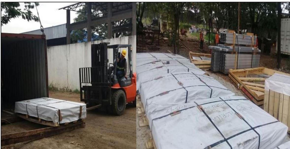
**Figura 8:** Descarga del contenedor que llega desde la fábrica de Florida con las piezas del reservorio a instalarse en Socio Vivienda 2- Capacidad 5000m<sup>3</sup>.
