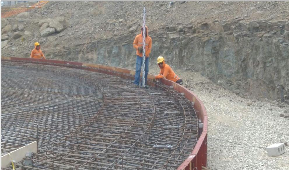
**Figura 55:** Nivelación de los anclajes niveladores de anillo.
