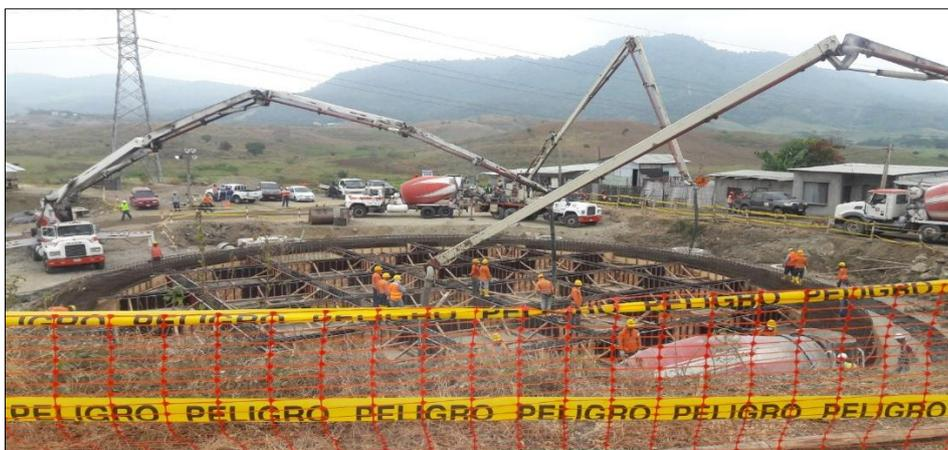
**Figura 40:** Utilización de tres plumas para hormigonar la cimentación.
