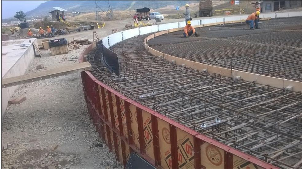
**Figura 56:** Colocación de la primera hoja de cimentación.
