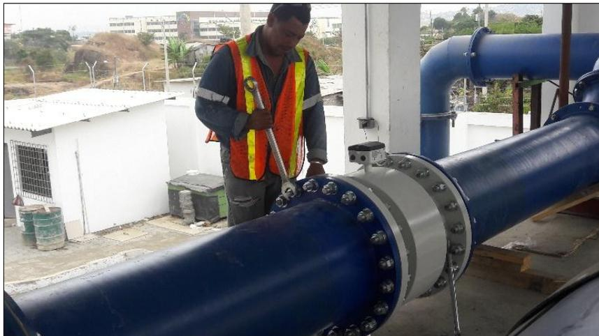
**Figura 15:** Instalación de brida.
