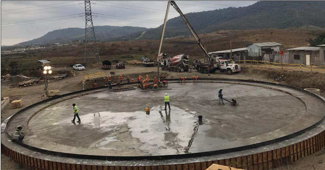
**Figura 59:** Pulido del piso de concreto.
