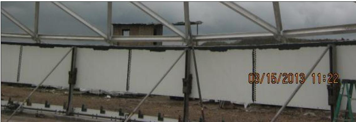
**Figura 52:** Gatas Hidráulicas para levantar los anillos..
