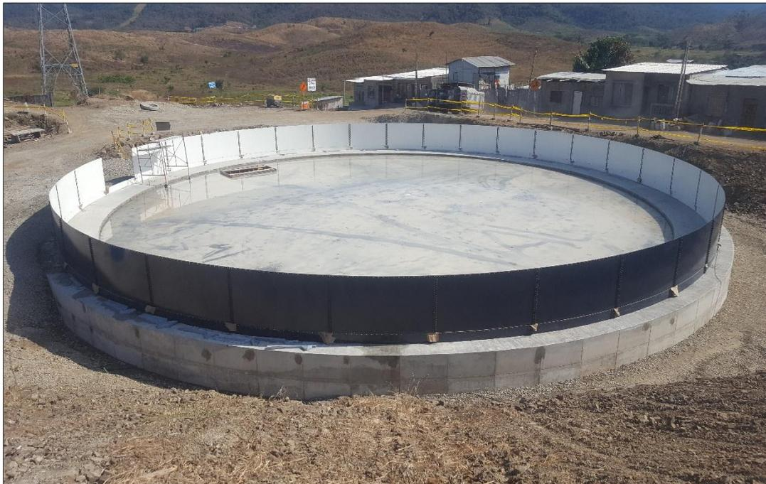
**Figura 64:** Armado del primer anillo de láminas de vidrio.
