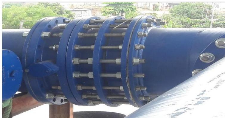
**Figura 11:** Junta de desmontaje.
