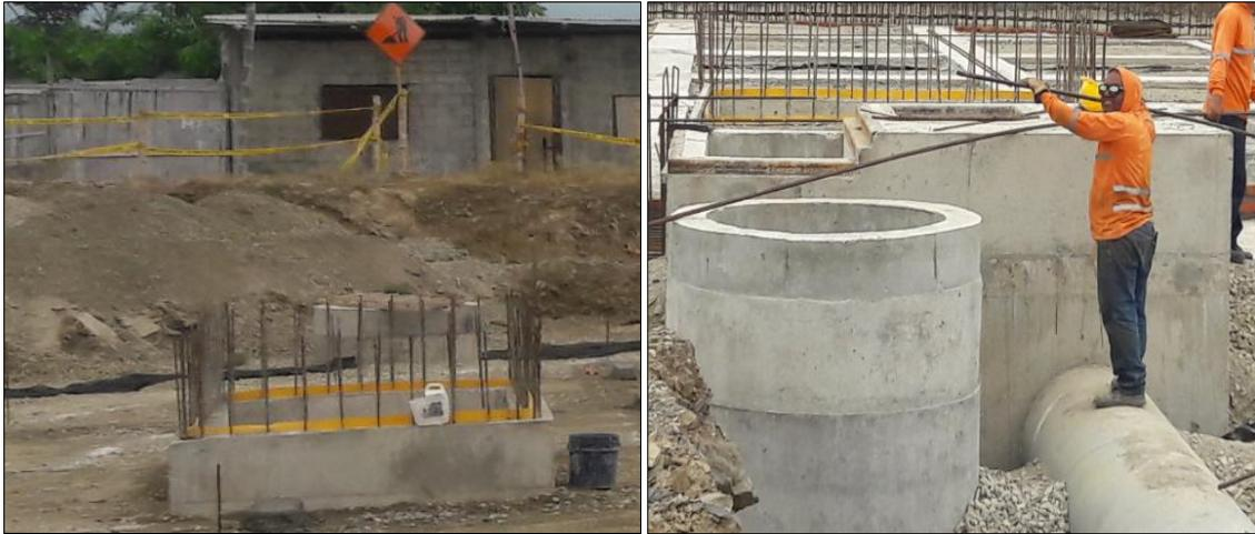
**Figura 35:** Instalación de armadura para estructura
