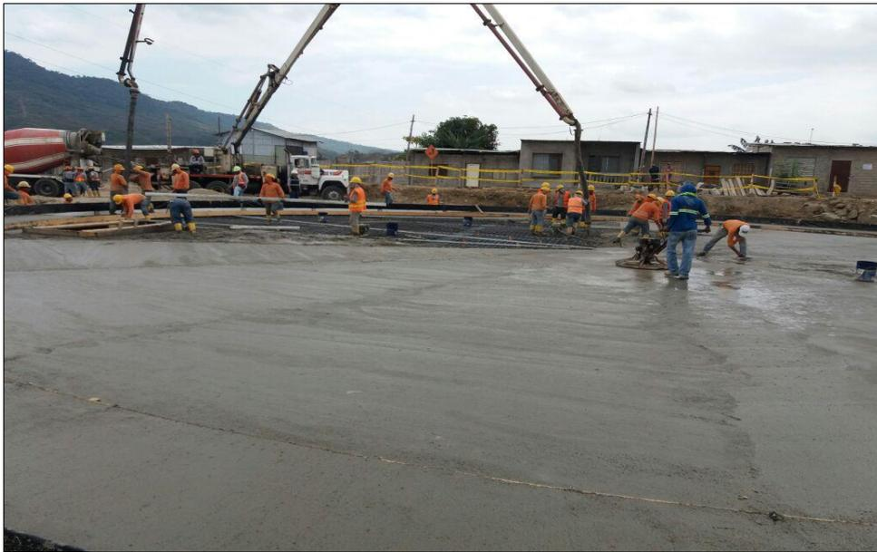
**Figura 58:** Colocación del piso de concreto.
