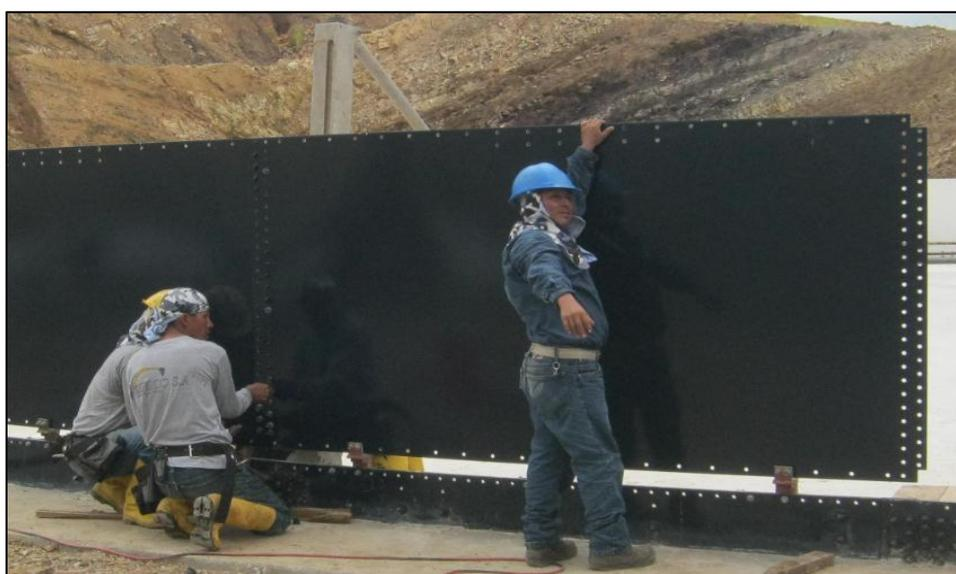
**Figura 4:** Colocación de láminas de vidrio fusionado al acero.
