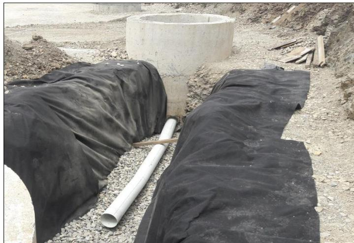
**Figura 27:** Colocación de piedra triturada
