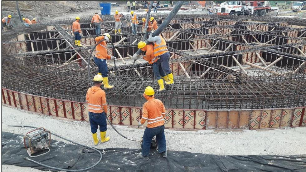
**Figura 42:** Vaciado del hormigón.
