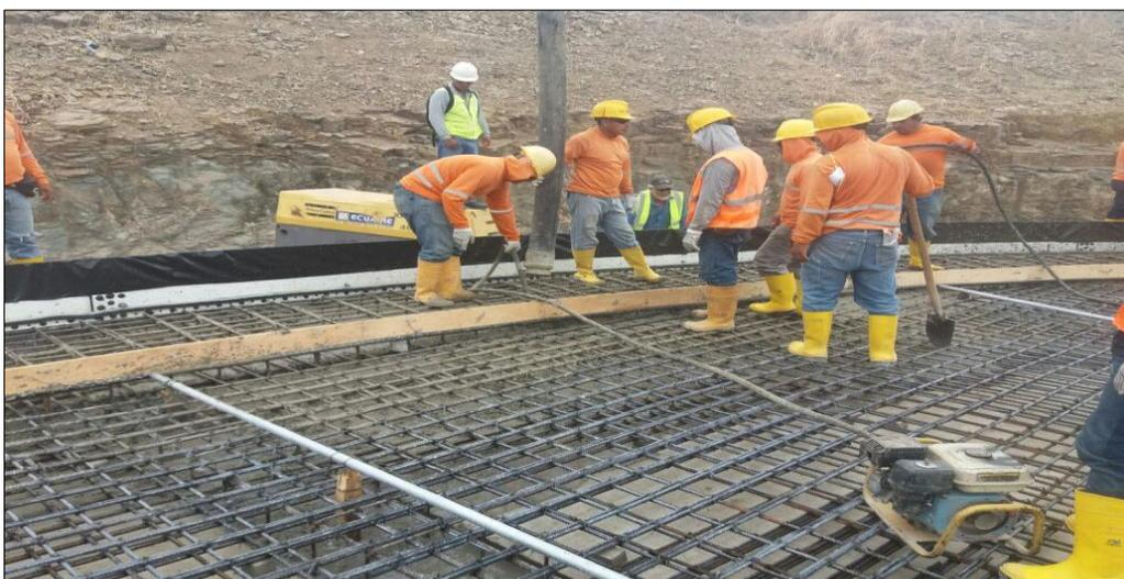
**Figura 57:** Colocación del concreto.
