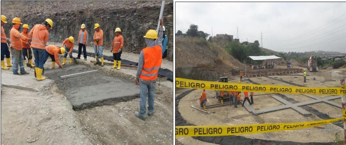
**Figura 34:** Construcción del replantillo
