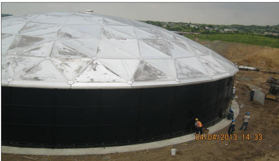
**Figura 7:** Reservorio en Urbanización Ciudad Victoria, capacidad 10,000 m<sup>3</sup>, 35m de diámetro y 10,50m de altura.
